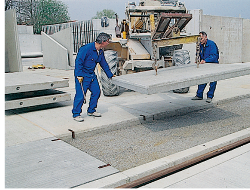
Pose avec palonnier
