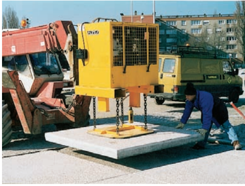
Pose par ventouses
