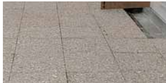
Revêtement en dalles grenillées.
