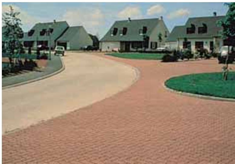
Aménagement urbain : utilisation judicieuse et complémentaire du béton coulé en place et des pavés béton.
