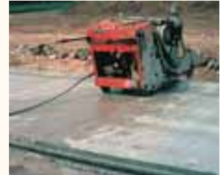
Réalisation d'un joint scié.
