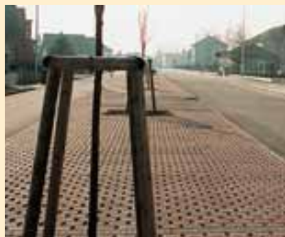
Large emprise et tracé rectiligne favorisant la vitesse (noter le terre-plein en pavés perméables).
