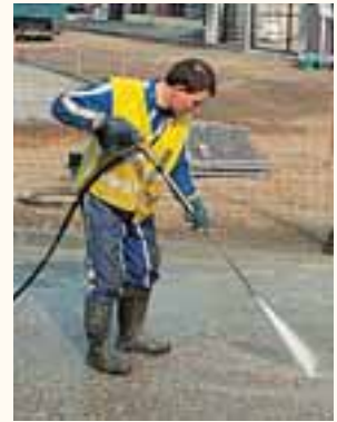
Béton désactivé : lavage au jet d'eau.
