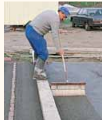
Brossage du béton.
