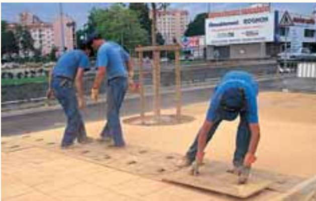
Béton imprimé : application des matrices.
