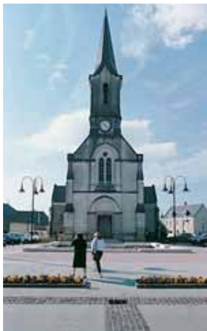
Revêtement urbain : exemple d'association entre béton coulé en place et éléments modulaires.
