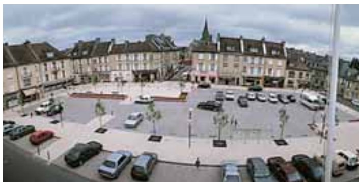
La voirie urbaine : structurer l'espace et améliorer sa lisibilité.
