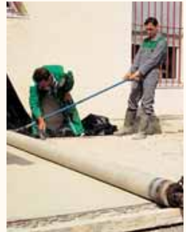
Mise en œuvre au striker.
