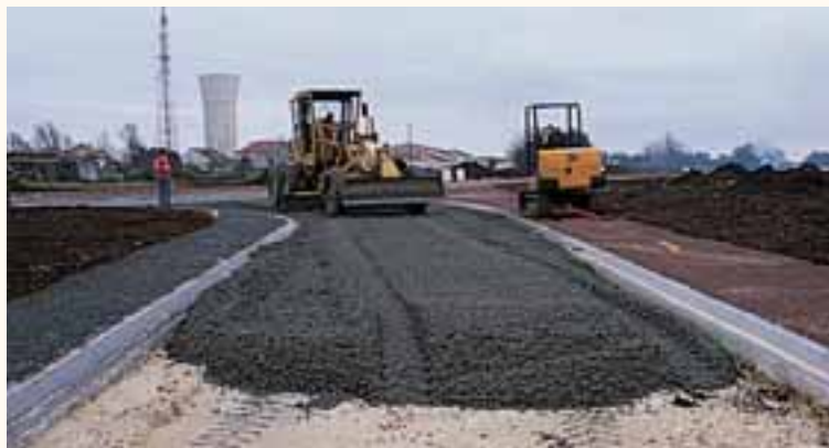
Mise en œuvre du béton poreux.
