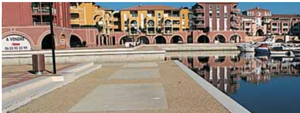
La voirie urbaine : modernité et intégration au site.
