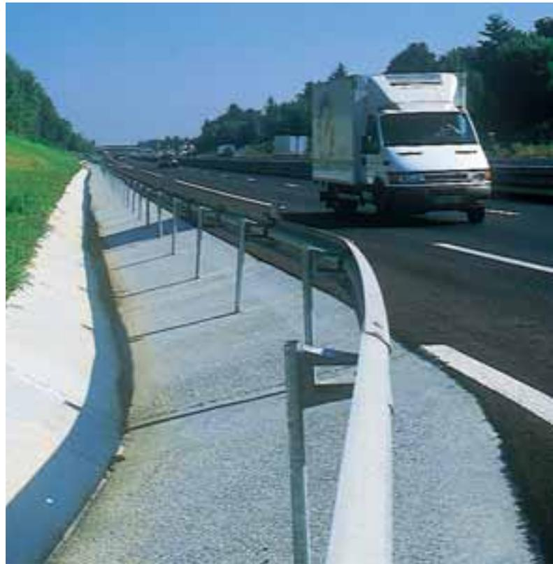
*Les ouvrages hydrauliques en béton permettent de respecter la loi sur l'eau et son obligation de recueillir puis de filtrer les eaux de ruissellement avant de les rejeter dans l'environnement.*
