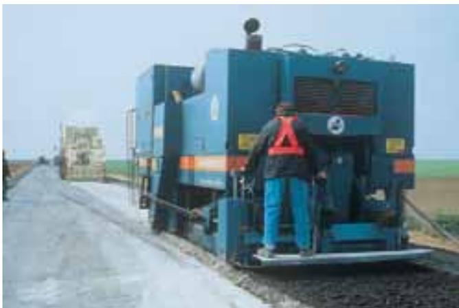
Le retraitement des chaussées en place au ciment ou aux liants hydrauliques routiers épargne les ressources en granulats et supprime les nuisances dues à leur transport.
