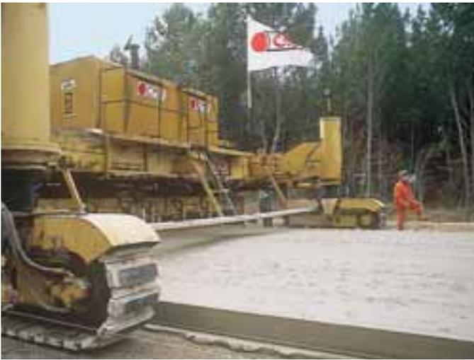
*Le béton peut aussi être formulé à partir du sable présent localement, comme sur cette route expérimentale en béton de sable, à la dune du Pyla (Landes)*
