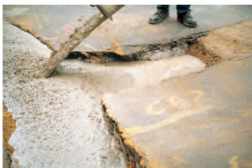
Fig. 9 : Remblayage de la tranchée.
