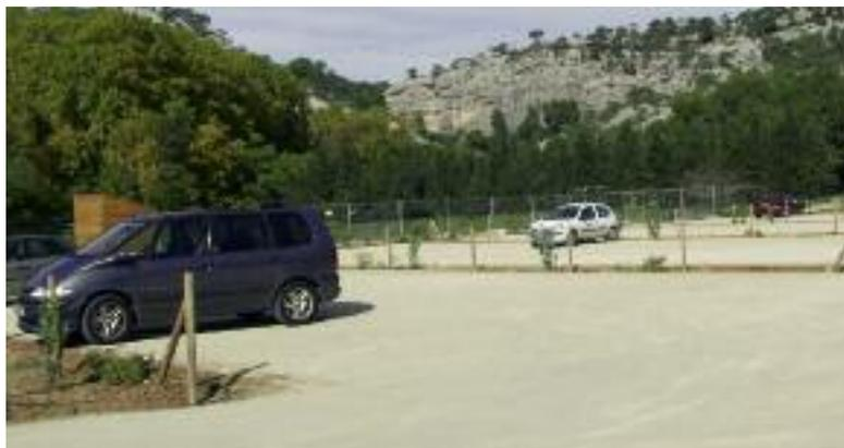
*Le Tholonet: intégration parfaite dans le paysage d'un parking réalisé avec un sable calcaire 0/4 mm stabilisé au ciment.*
