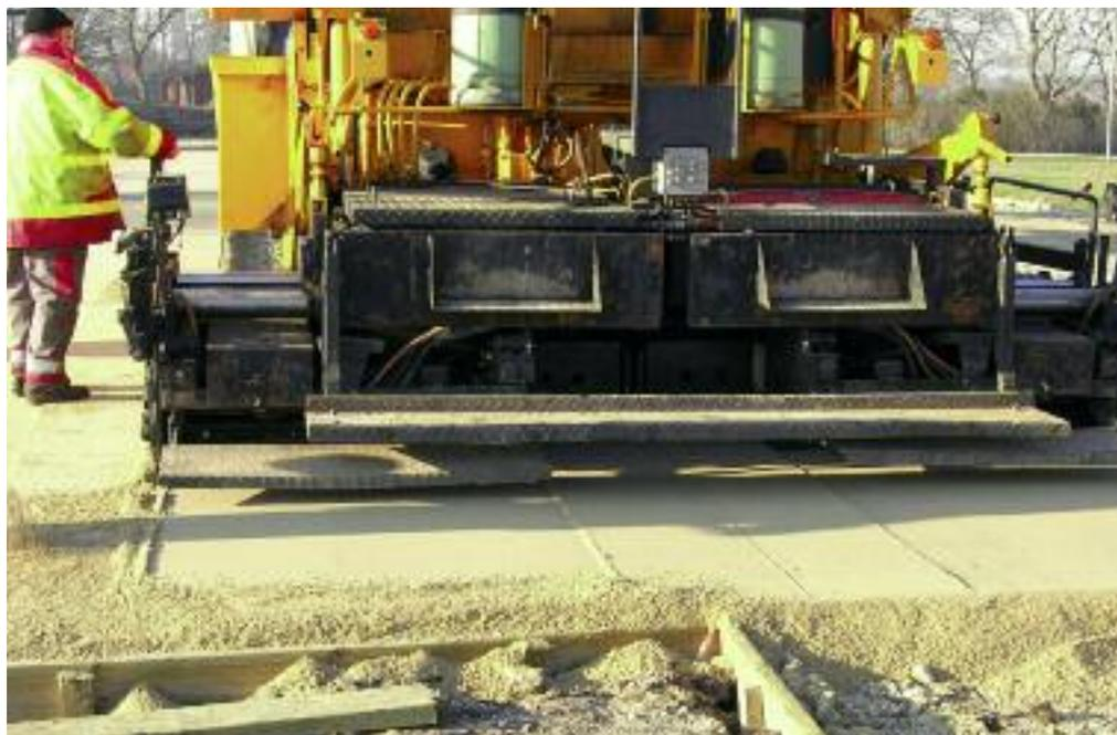
*Mise en œuvre d'un matériau stabilisé à l'aide d'un finisseur.*
