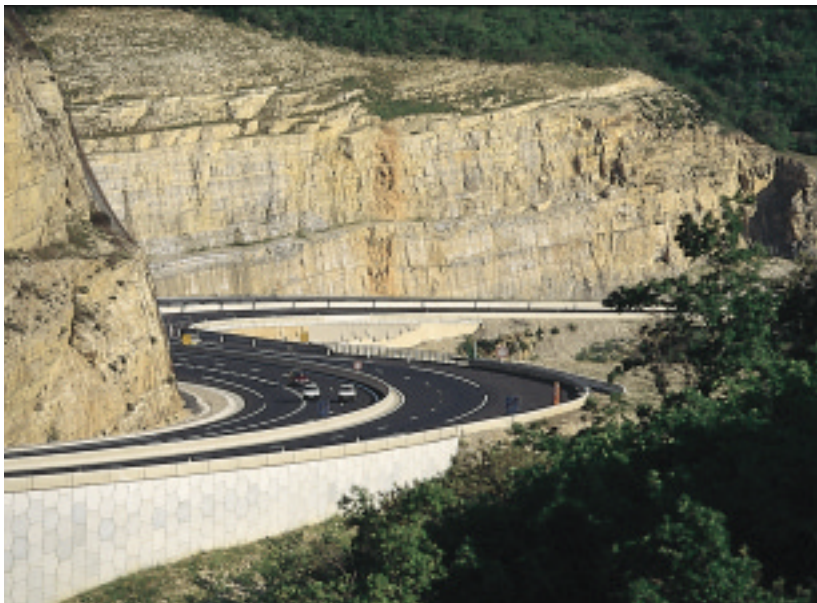
Dispositifs de retenue sur les routes sinueuses de montagne...
