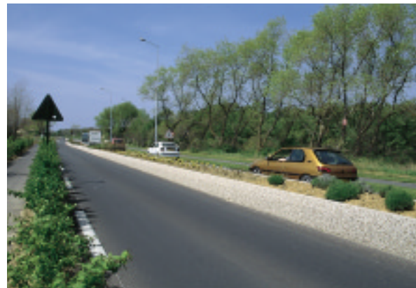
Dispositif de sécurité dans une zone périurbaine.
