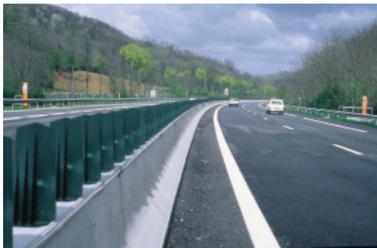
Une protection anti-éblouissement est associée à la glissière en béton.
