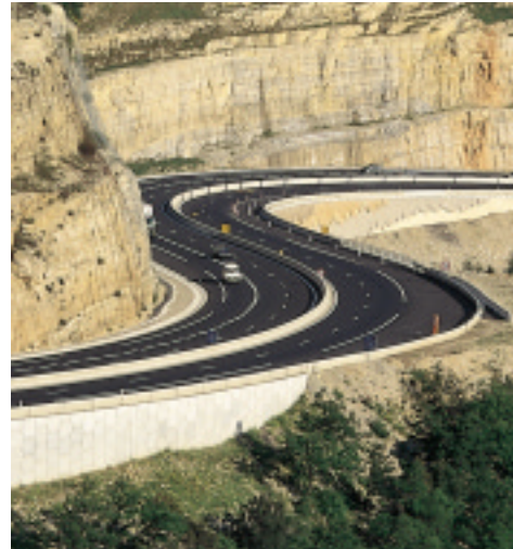
Dispositifs de sécurité sur une route de montagne.
