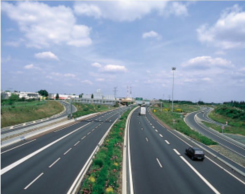
Double glissière végétalisée en site périurbain...
