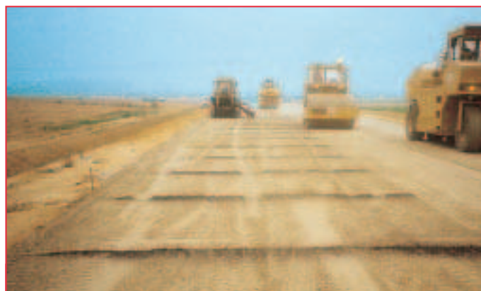
L'atelier de compactage suit la machine de préfissuration. Les joints exécutés sont espacés de 2 à 3 mètres.
