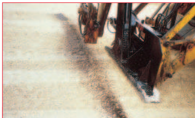
Procédé CRAFT® : le soc projette simultanément, sur les parois du sillon, une émulsion de bitume.
