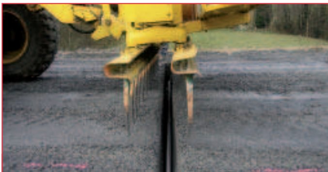
Insertion, dans le sillon, d'un joint en profilé plastique rigide, de forme sinusoïdale.
