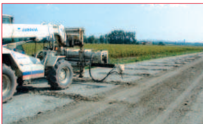
OLIVIA® en action : préfiissuration sur toute la largeur de la chaussée, élargissements compris.
