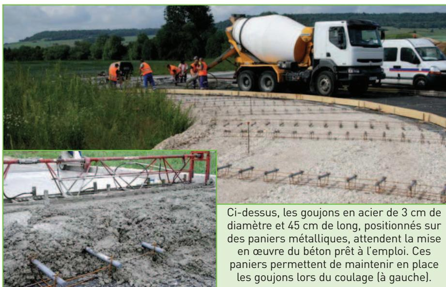
Ci-dessus, les goujons en acier de 3 cm de diamètre et 45 cm de long, positionnés sur des paniers métalliques, attendent la mise en œuvre du béton prêt à l’emploi. Ces paniers permettent de maintenir en place les goujons lors du coulage (à gauche).
