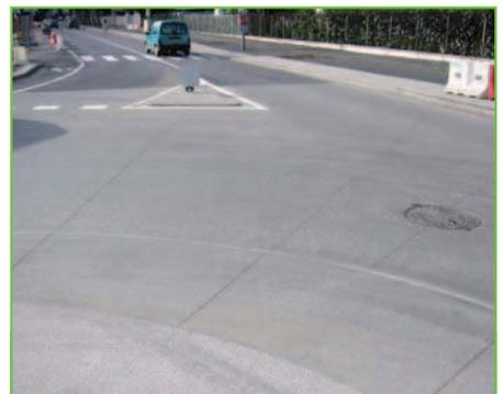
Le calepinage des joints de la chaussée dessine une sorte de toile d'araignée.
