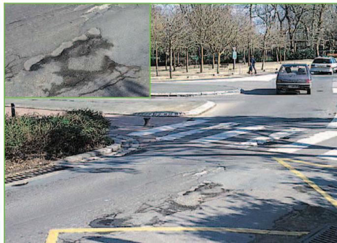
Dégradations superficielles observées sur les voies d'accès : arrachement des gravillons, plissement des couches de surface et départ en plaques.
