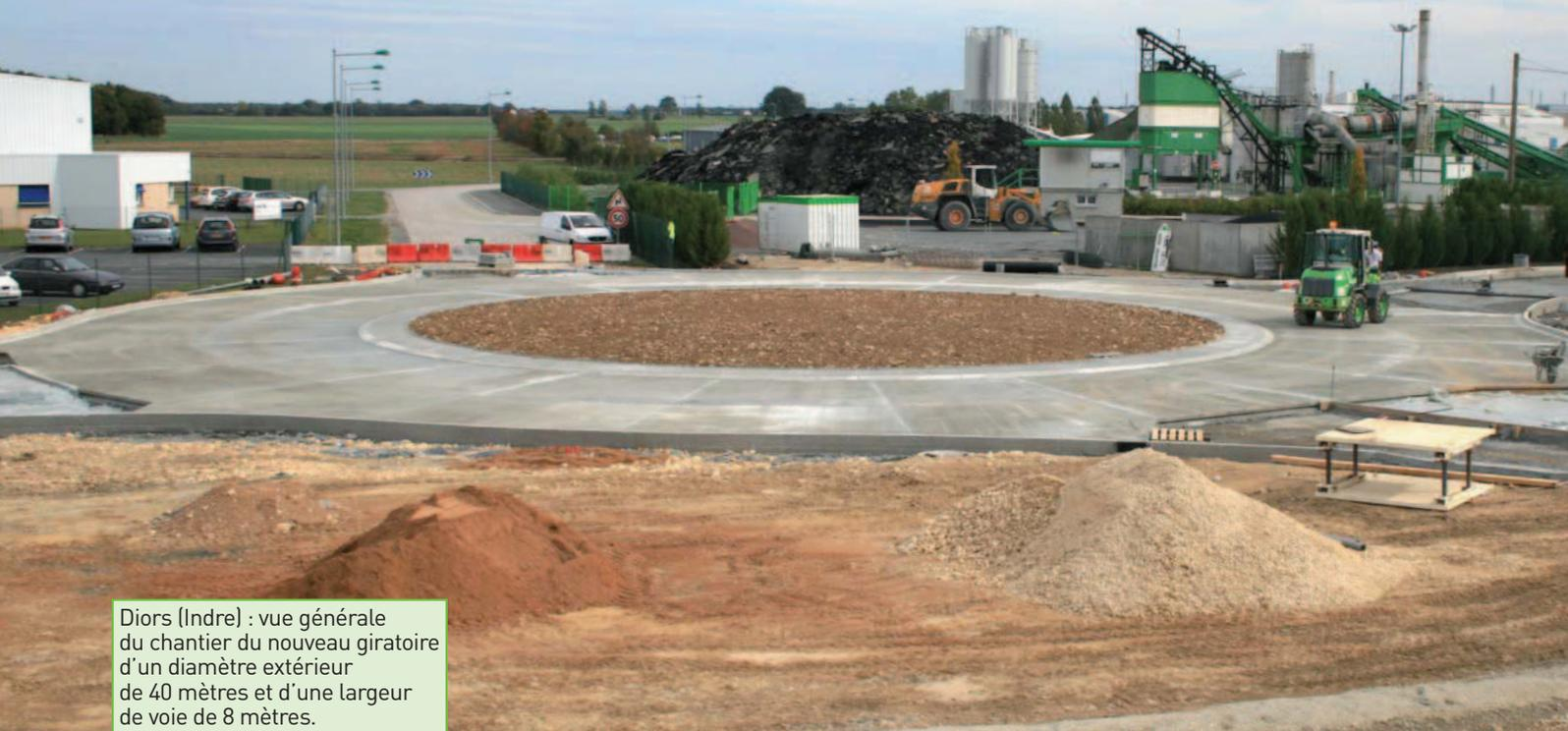
Diors (Indre) : vue générale du chantier du nouveau giratoire d'un diamètre extérieur de 40 mètres et d'une largeur de voie de 8 mètres.
