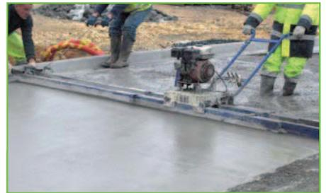
La règle vibrante prend appui sur les coffrages et les bordures.
