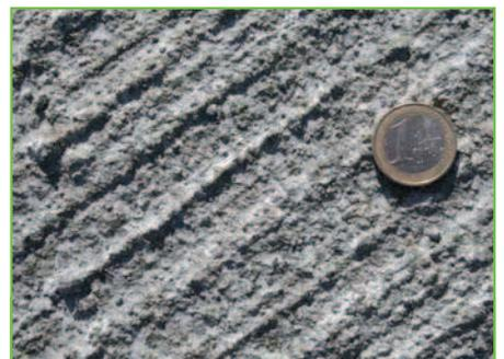
Le béton balayé donne sa texture anti-dérapante à la couche de roulement.
