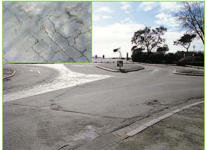
Dégradations structurelles observées sur les carrefours giratoires : faïençage et orniérage des couches de surface.
