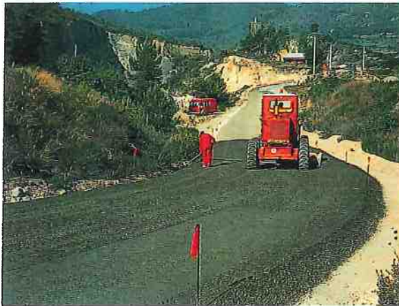
Compactage au rouleau vibrant.
