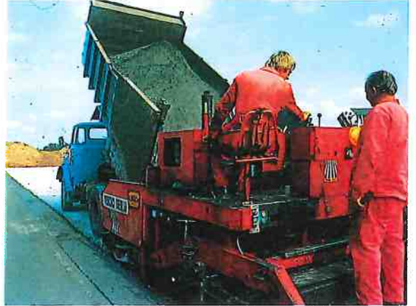
Camion-benne déversant le béton dans le finisseur.
