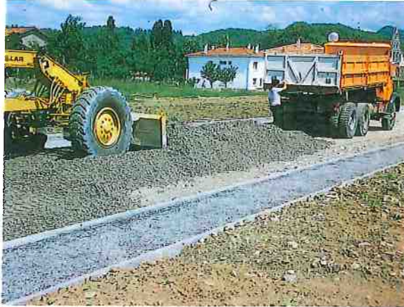
Camion-benne ayant déversé le béton devant la niveleuse.
