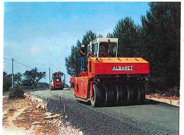
Compactage au rouleau à pneus.
