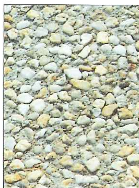
Béton désactivé avec granulats roulés.
