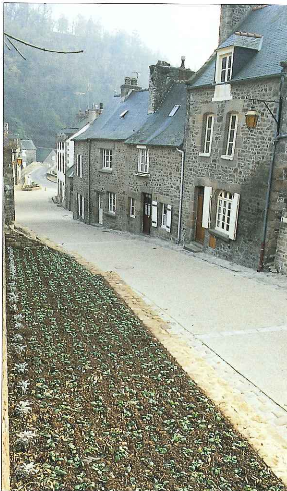
Le béton désactivé en traversée de ville.
