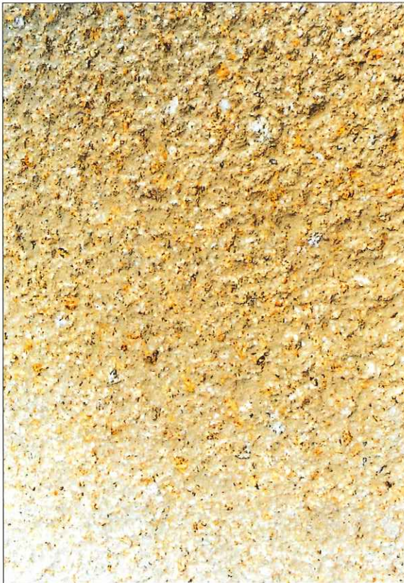
Aspect d'un béton bouchardé.
