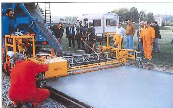
Mise en œuvre au vibro-finisser.
