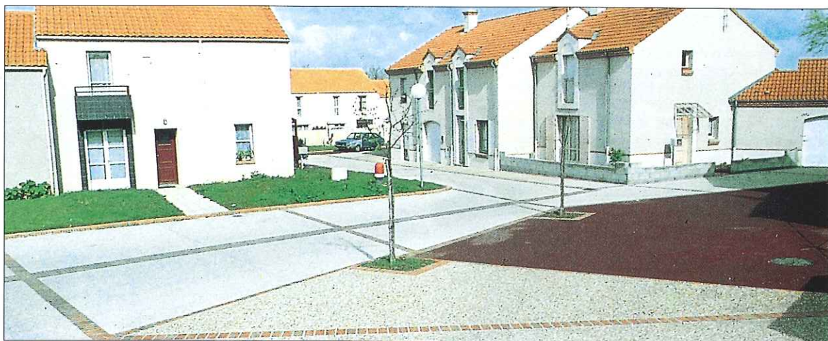
Voirie de lotissement en béton désactivé.
