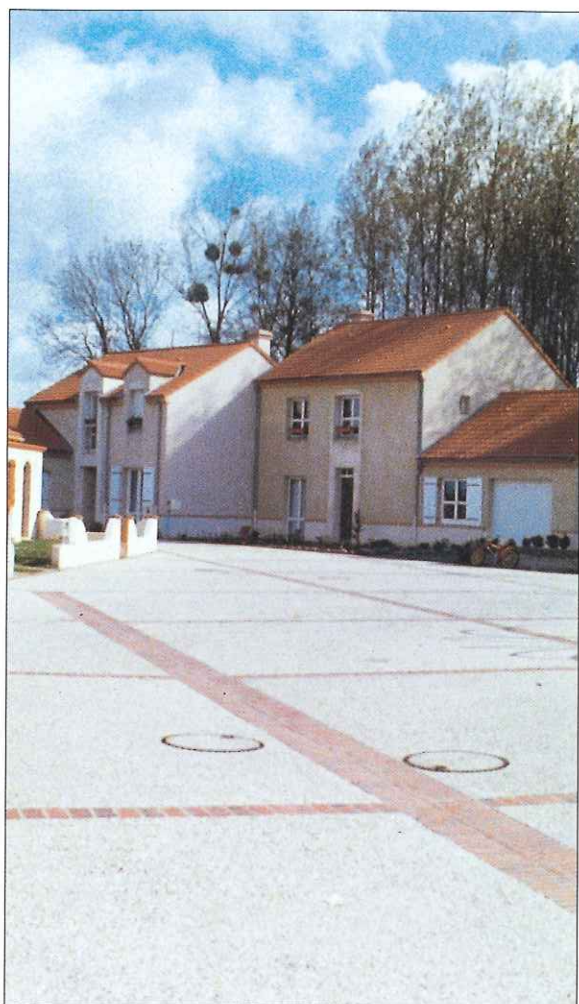
Voirie de lotissement en béton désactivé.
