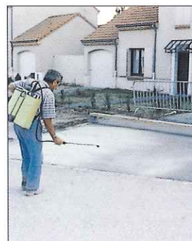
L'application du désactivant.
