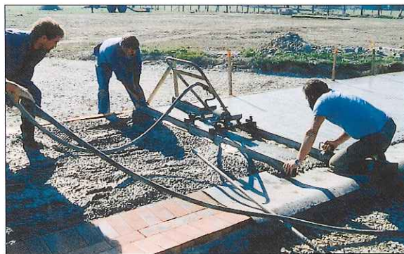
Mise en œuvre à la règle vibrante.
