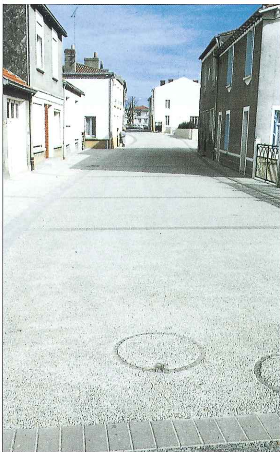
Le béton désactivé pour la qualité du profil et de la finition.
