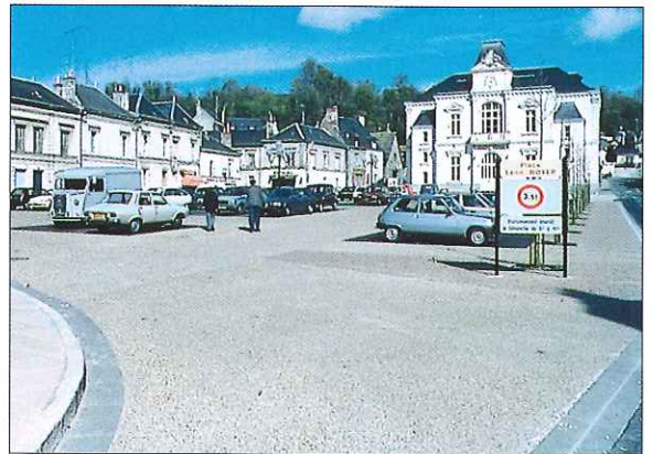
Le béton désactivé pour l'aménagement d'un centre ville.
