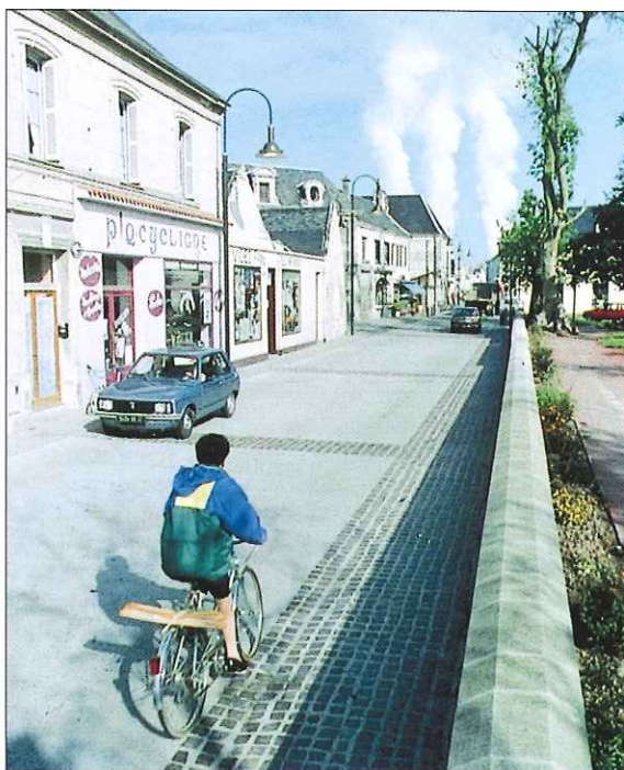
Le mariage "béton désactivé-pavés" pour faciliter les accès aux réseaux enterrés.
