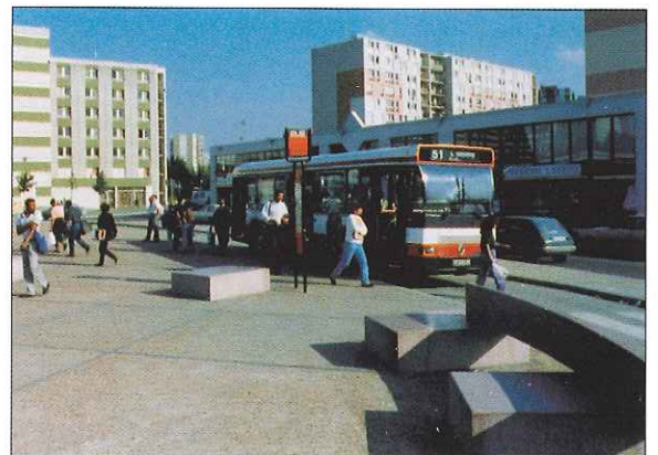
Le béton désactivé pour résister à la canalisation des charges.
