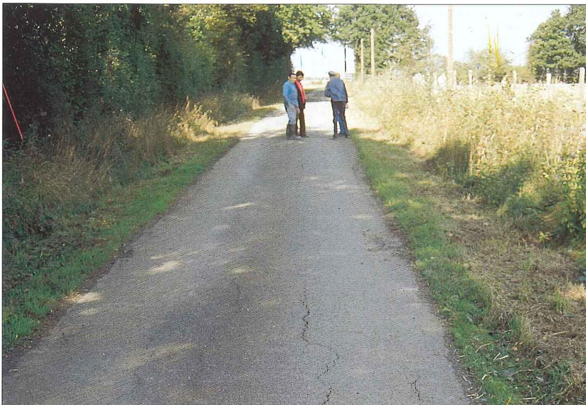
*Chaussée dégradée : fissures de fatigue et déformations visibles en surface.*
