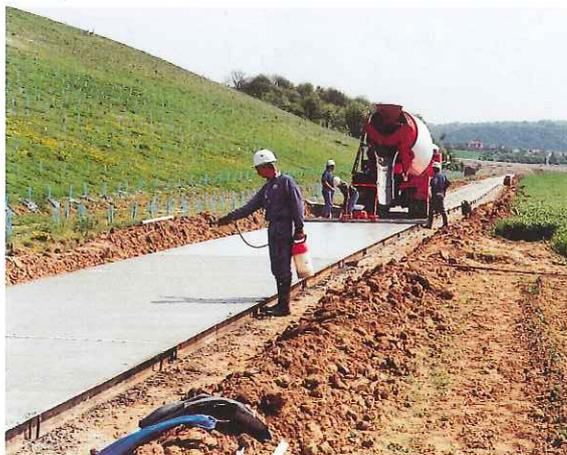
La cure du béton frais : pulvérisateur manuel de type agricole.
