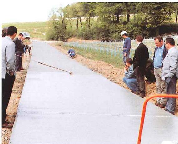
Le brossage de la surface du béton frais à l'aide d'un balai.
