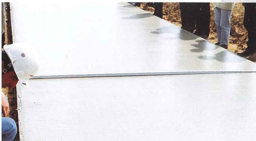
Le moulage d'un joint transversal dans le béton frais.
