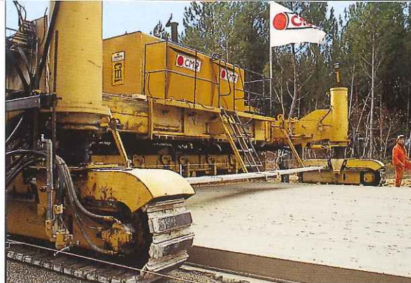
L'état du revêtement en béton de sable à la sortie de la machine à coffrage glissant.
