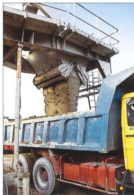
La fabrication en centrale et le transport des bétons de sable.
