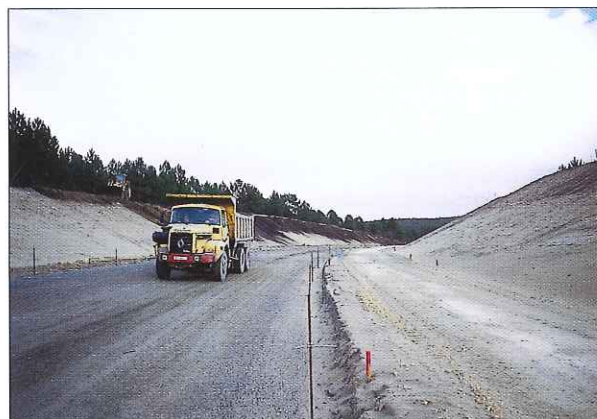
Plate-forme de bonne qualité pour recevoir la chaussée en béton de sable. Cette plate-forme a été réalisée par traitement du sable en place au ciment.
