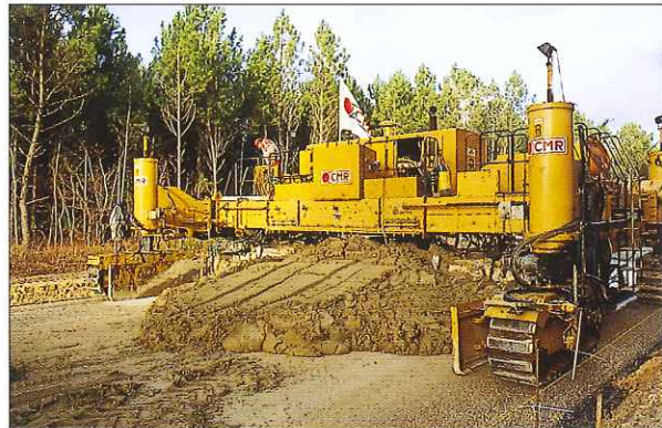
La mise en œuvre du béton à la machine à coffrage glissant.
