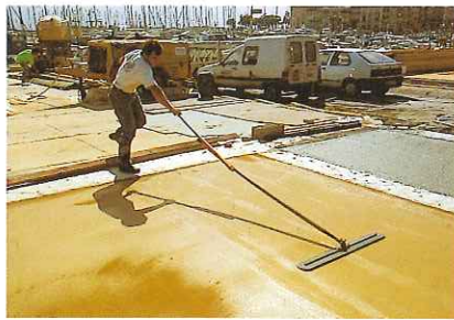
▲ ... puis incorporée dans le béton à l'aide d'une lisseuse.
