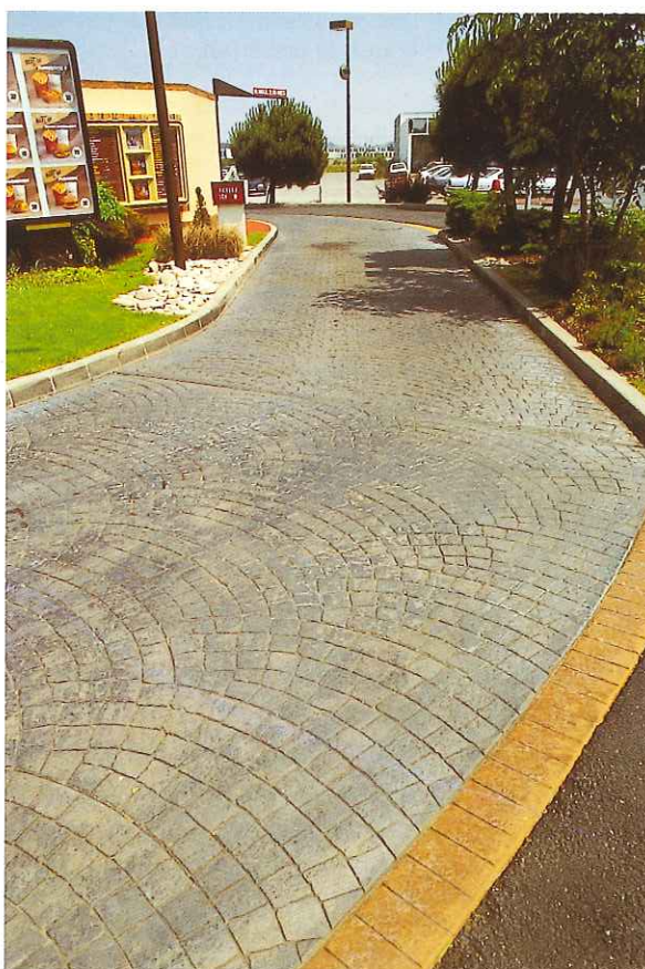
▲ Voirie en béton imprimé : aspect de pavés romains.
