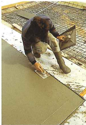
◀ La lisseuse en quart-de-rond permet d'arrondir le bord du revêtement, écartant ainsi tout risque d'épaufrures.
