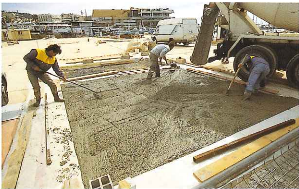
▲ L'approvisionnement du béton et sa mise en œuvre.
