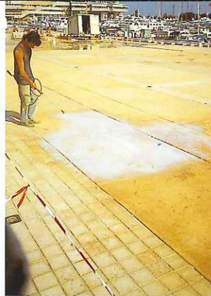
▲ Application de la couche de protection.
