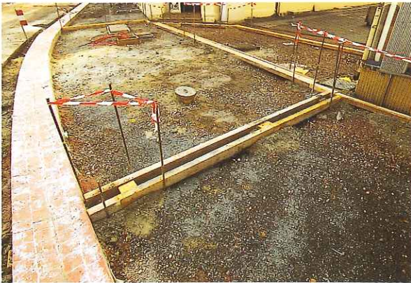
▲ Préparation du chantier : pose des coffrages, signalisation.
