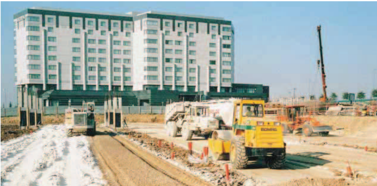
▲ Vue générale d'exécution d'une plate-forme industrielle. Assises en limon traité à la chaux et au ciment.
