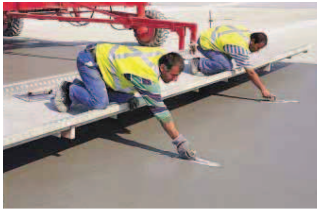
▲ Une taloche automatique montée à l'arrière de la machine effectue dans un mouvement de va-et-vient un premier lissage de la surface du béton. L'opération est complétée par un lissage manuel à la taloche. Une toile de jute traînée à l'arrière de la passerelle complète la finition.
