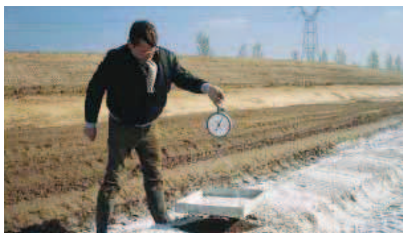
▲ Contrôle de l'épandage du liant.
