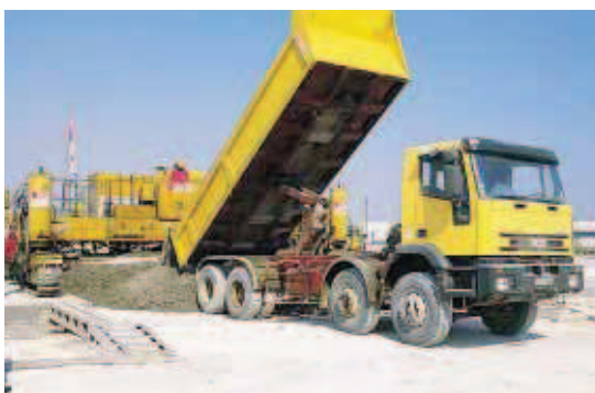
▲ Le béton acheminé par camion est déversé à l'avant de la machine à coffrages glissants.
