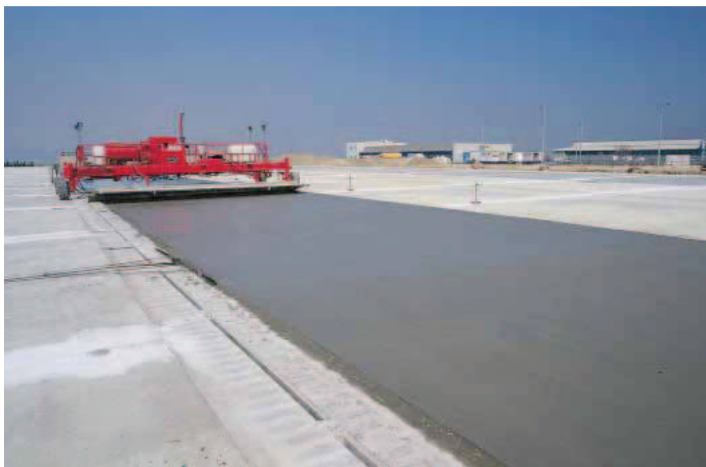
▲ Plus de 20 000 m 3 de béton ont été mis en œuvre en l'espace de 7 mois sur la plate-forme aéroportuaire de Marseille-Provence. Ce chantier de grande envergure fait appel à des moyens humains et matériels importants.
