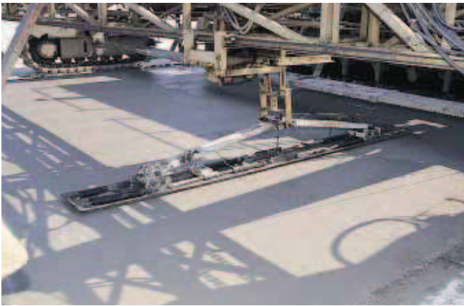
▲ Une taloche automatique montée à l'arrière de la machine effectue dans un mouvement de va-et-vient un premier lissage de la surface du béton. L'opération est complétée par un lissage manuel à la taloche. Une toile de jute traînée à l'arrière de la passerelle complète la finition.
