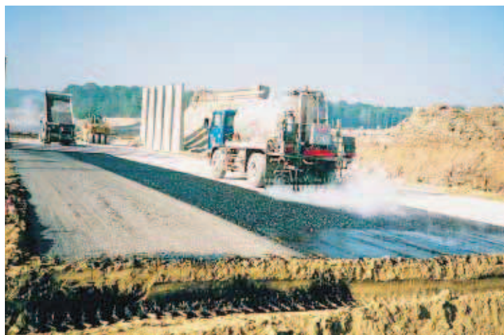
▲ Protection de l'assise de limon traité.
