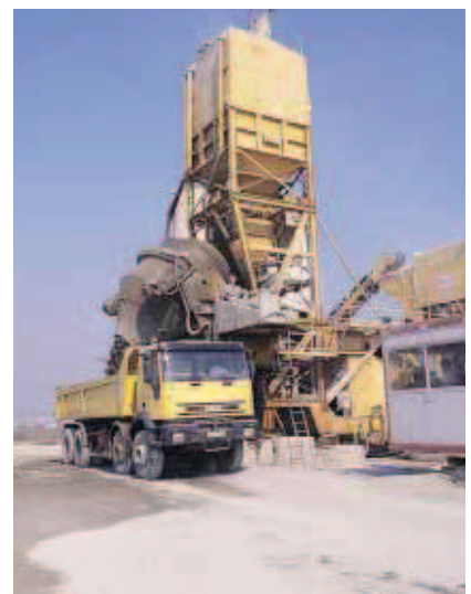
▲ La centrale est configurée sur ce chantier pour fournir 150 à 180 m 3 /h de façon discontinue – alors qu'elle pourrait atteindre 350 m 3 /h avec une configuration légèrement différente par montage d'un pré-malaxeur –, gâchées de 7 m 3 , afin de répondre aux à-coups des travaux.
