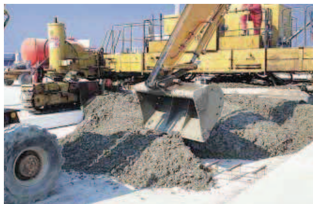
▲ Une pelle hydraulique déverse du béton sur les goujons afin de les immobiliser avant le passage de la machine à coffrages glissants.
