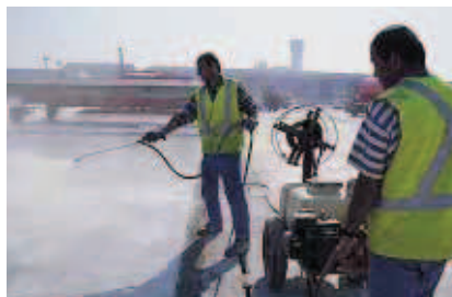
▲ Un produit de cure protège le béton de la dessiccation pendant les premières heures nécessaires à la montée en résistance.
