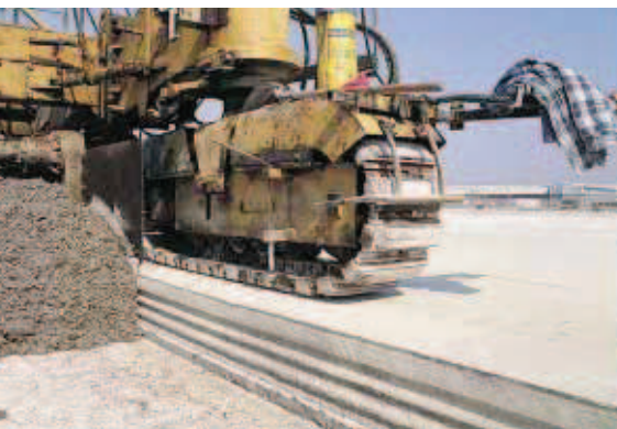
▲ Les flancs ondulés des dalles primaires solidarisent les dalles de béton entre elles afin d'assurer un transfert de charges parfait.
