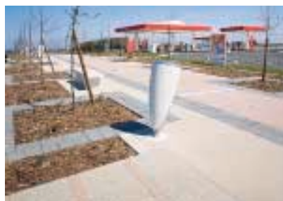
Dalles et pavés lavés.
