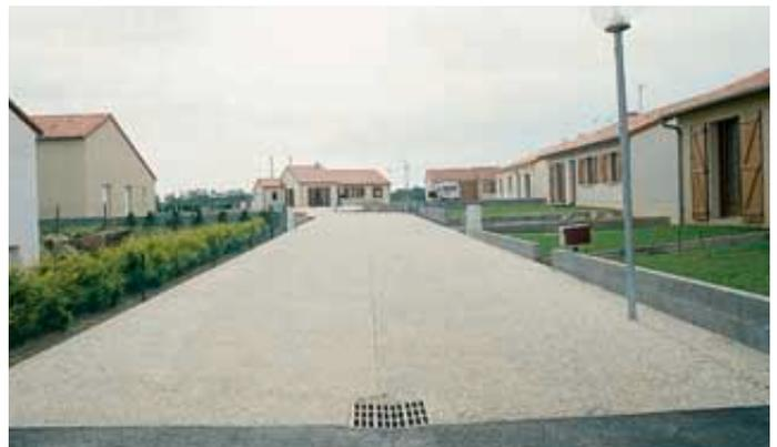
Afin d'assurer la sécurité et le confort des usagers (aquaplanage, projections d'eau) il faut évacuer rapidement l'eau de la surface de la chaussée. Un profil en travers adapté, avec dévers d'au moins 2%, canalisera l'eau soit au milieu de la chaussée, soit latéralement. L'eau sera ensuite évacuée de façon classique par des caniveaux et des avaloirs judicieusement placés.
