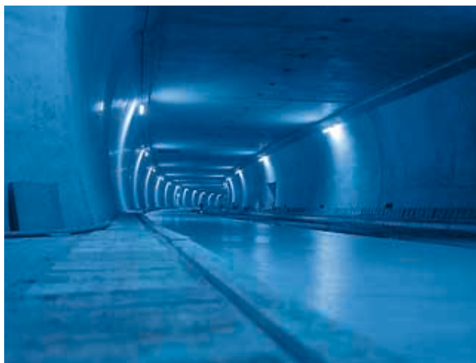
La luminosité du béton améliore la visibilité et permet d'économiser sur les coûts et les équipements d'éclairage.
