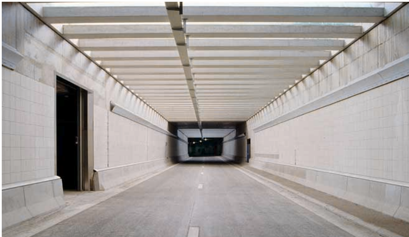
La liaison autoroutière entre l'E40 et l'E25 à Liège, en Belgique, est traitée intégralement en béton armé continu (BAC).
