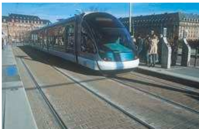
Tramway de Strasbourg : la technique béton facilite l'intégration des moyens de transport collectif.
