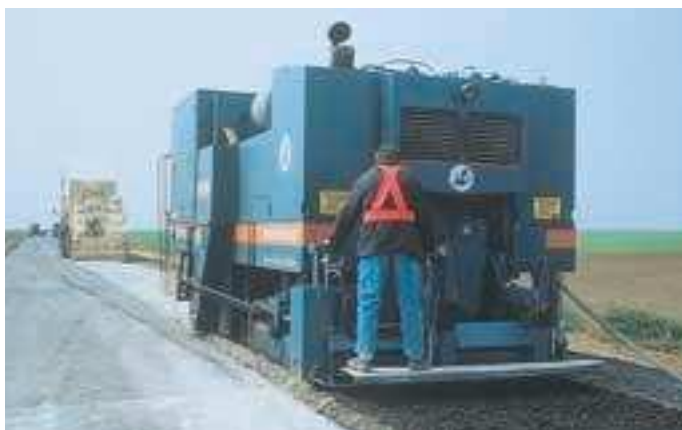
Le retraitement du sol en place au moyen de liants hydrauliques routiers épargne les ressources en granulats et supprime les nuisances dues à leur transport.
