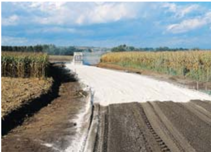
Épandage de liant pulvérulent sur la chaussée fragmentée à retraiter.
