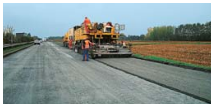
La technique du retraitement en place peut aussi être utilisée pour créer un élargissement de la chaussée à retraiter.
