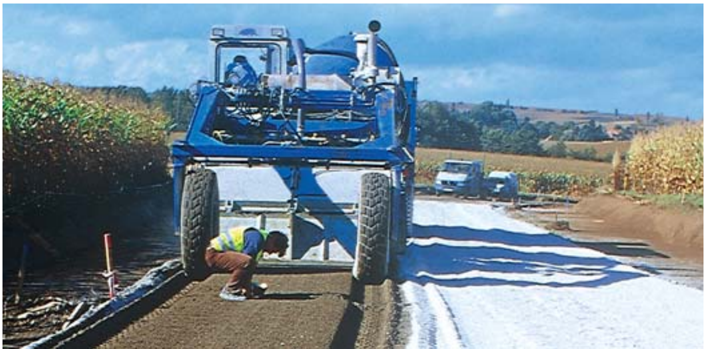
Retraitement in situ servant à renforcer la RD 32 (Bas-Rhin).
