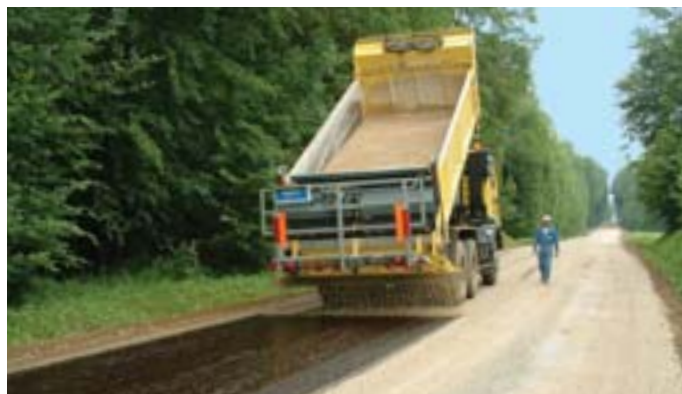
Protection de surface de la couche traitée.
