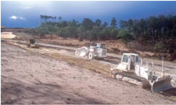
Vue générale d'un chantier de traitement de sol.
