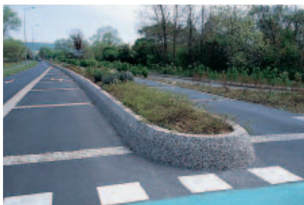
En béton désactivé et végétalisées, les glissières béton contribuent à la qualité de l'aménagement urbain.
