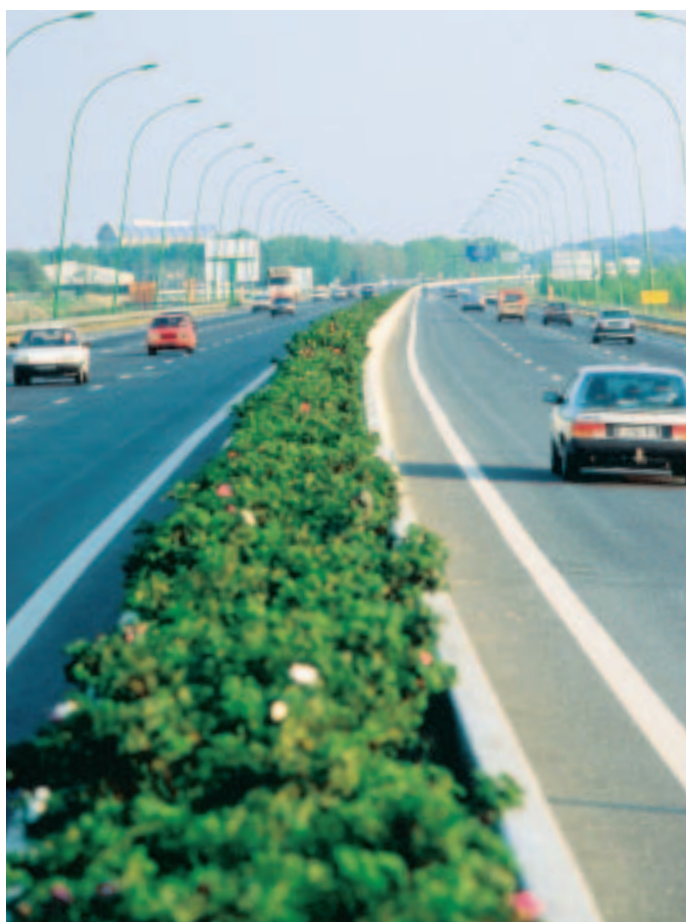
La double glissière végétalisée contribue efficacement à la qualité de l'environnement.
