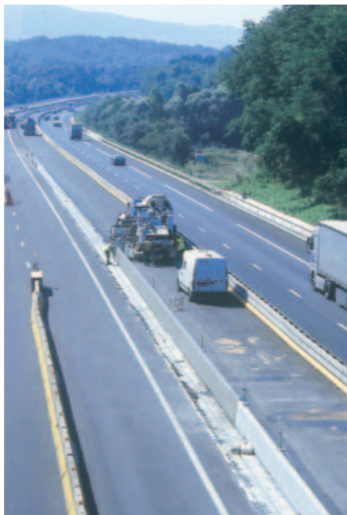
Autoroute A40 : réalisation de glissières de sécurité en béton armé, pérennes et faciles à entretenir.
