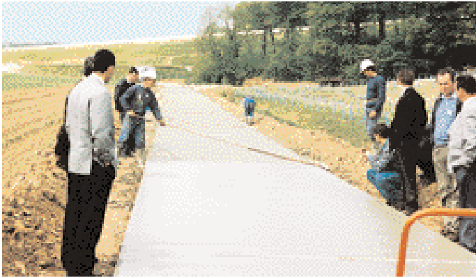
Brossage de la surface du béton frais à l'aide d'un balai.
