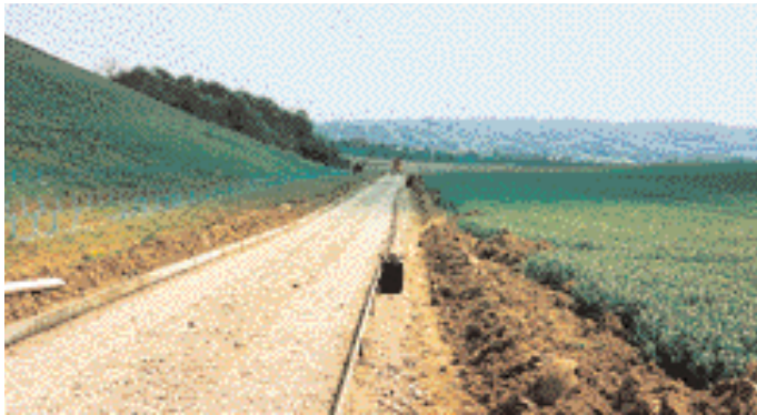
Plate-forme et coffrages exécutés.
