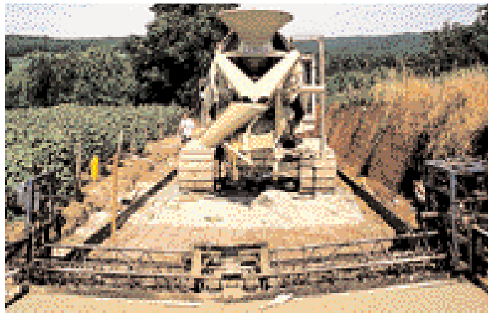
Mise en œuvre au vibrofinisseur.
