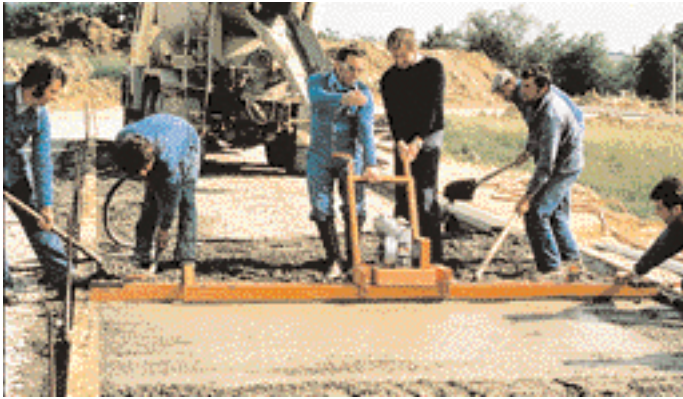
Mise en œuvre à la règle vibrante.
