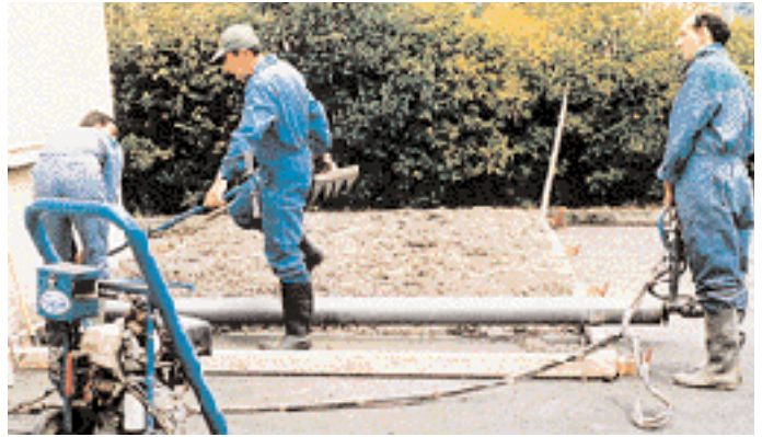
Mise en œuvre au Stricker.
