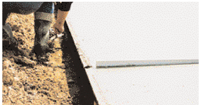
Moulage d'un joint transversal dans le béton frais.
