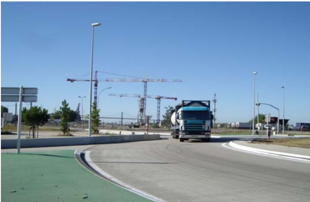
Photo 1 : Giratoire en béton armé continu (Z.I.P. BASSENS 33)
