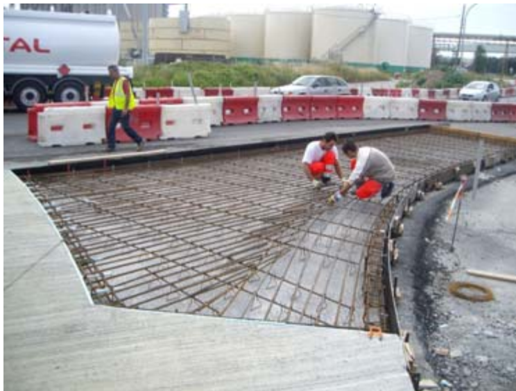
Photo 5 : Ferrailage d'une amorce de giratoire en béton armé continu (Crédit photo : CMR Exedra)
