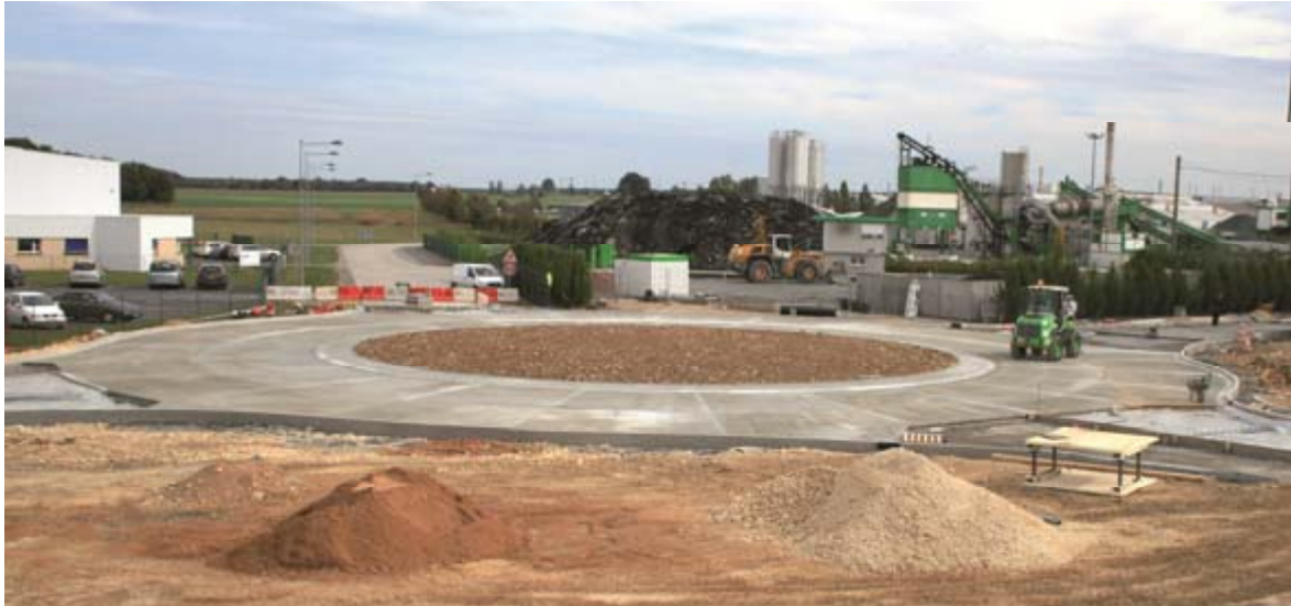
Photo 14 : Vue d'un giratoire en béton goujonné (Crédit photo : CIMBETON)
