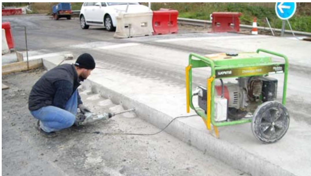
Photo 17 : Forage pour ancrage de barres d'aciers (Crédit photo : CMR Exedra)
