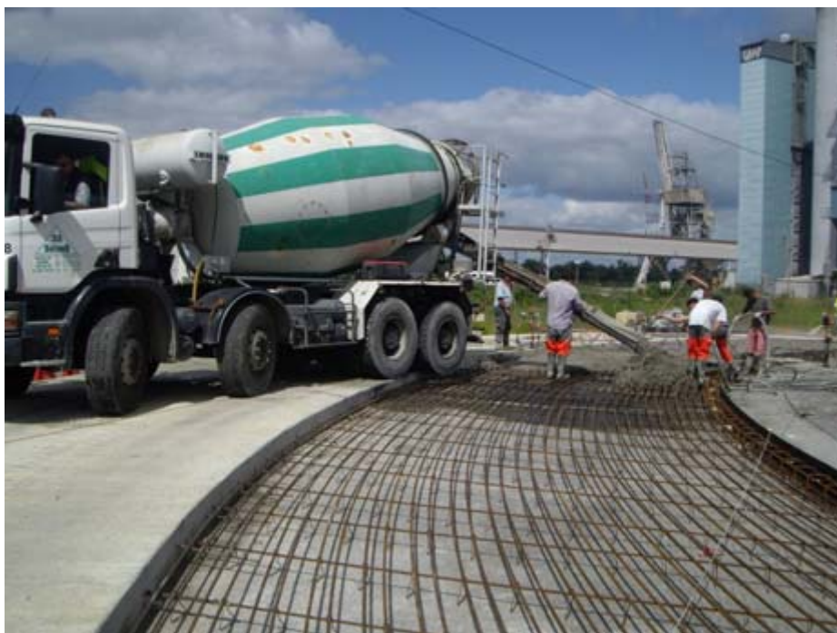
Photo 2 : Coulage du béton sur un giratoire en béton armé continu
