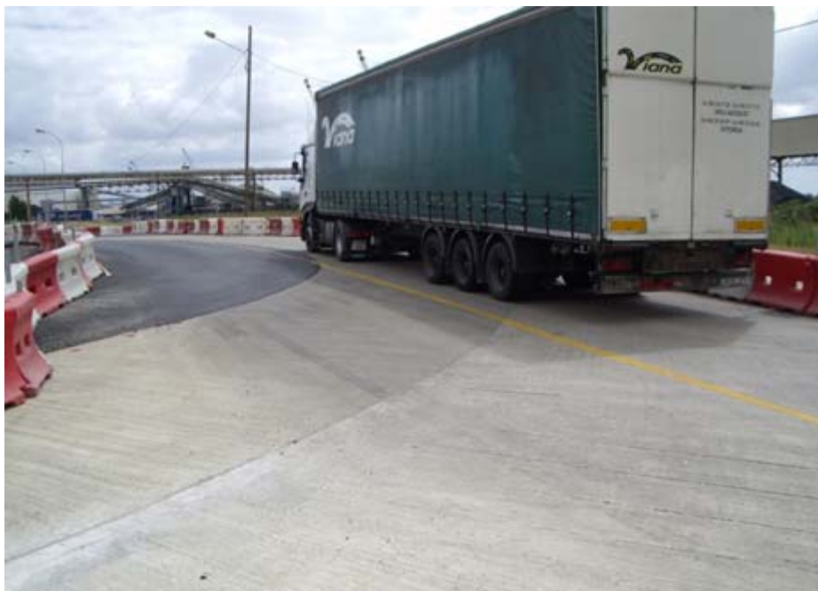
Photo 4 : Circulation pendant les travaux
