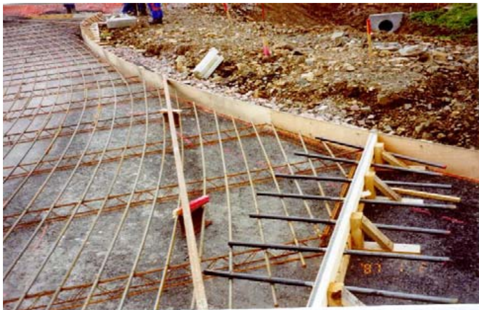
Photo 13 : Exemple de ferrailage entre l'anneau et l'amorce de chaussée pour un giratoire en BAC
