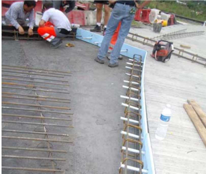
Photo 7 : Joint de dilatation avec goujons et chaînage
