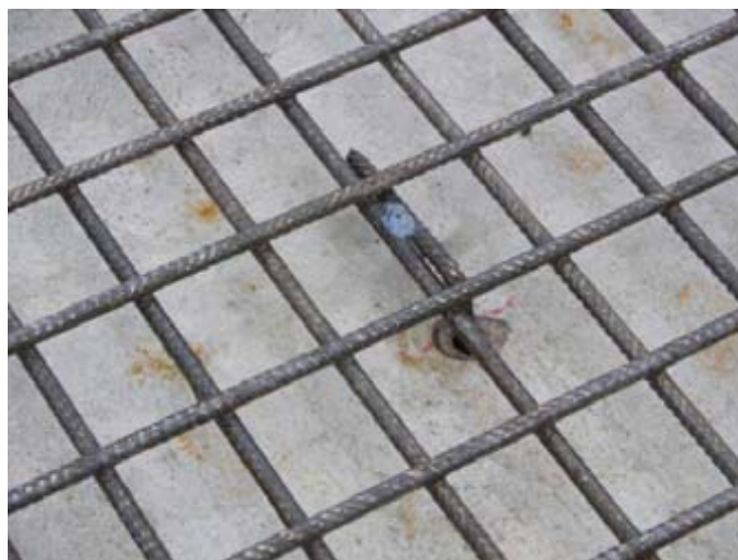
Photo 18 : Fixation du treillis soudé sur le support du BHP
