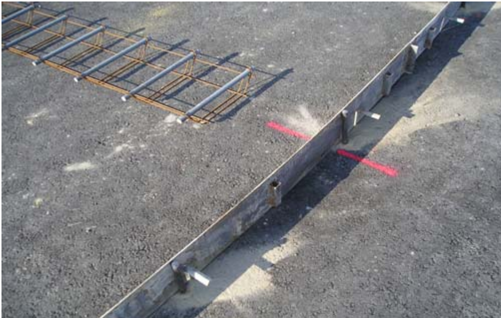
Photo 12 : Positionnement des paniers de goudons avant bétonnage du giratoire
