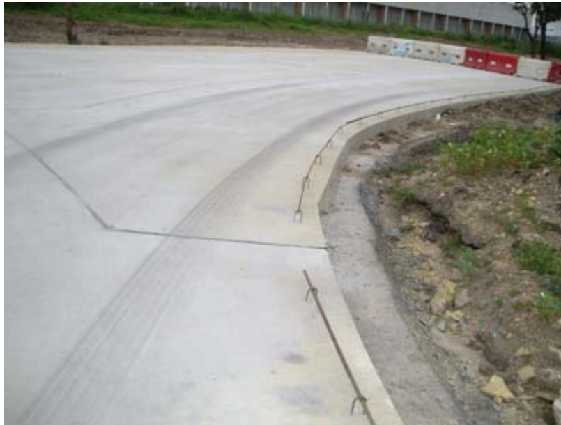
Photo 9 : Attente pour bordure en béton coulé en place (Crédit photo : CMR Exedra)
