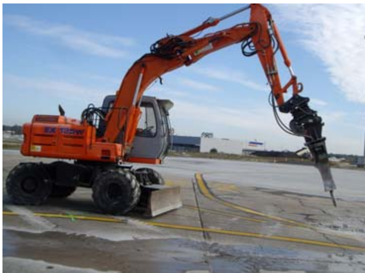
Photo 15 : Démolition au BRH
