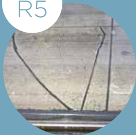
LE SCIAGE ULTÉRIEUR D'UN JOINT
