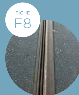
FISSURE LE LONG D'UN JOINT LONGITUDINAL OU D'UN RAIL CENTRAL
