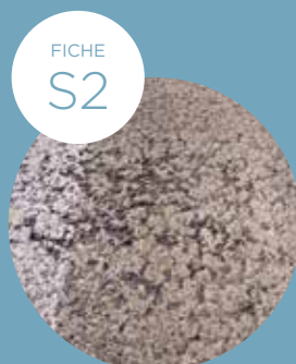
ECAILLAGE OU FAÏENCAGE DE SURFACE
