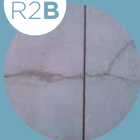
LE SCHELLEMENT DE FISSURE AVEC UNE RÉSINE
