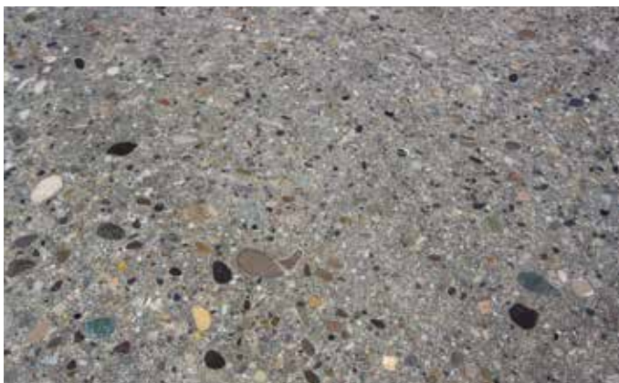
Surface de béton poncée
