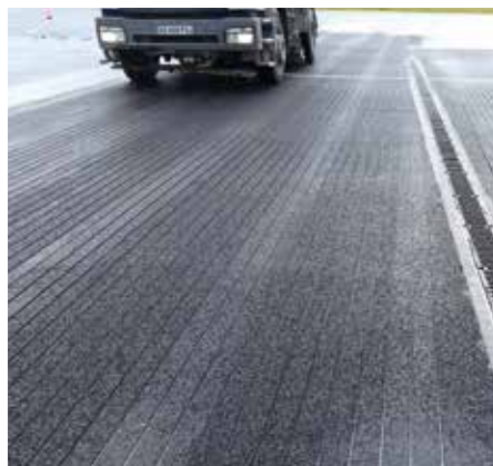
Surface de béton rainurée
