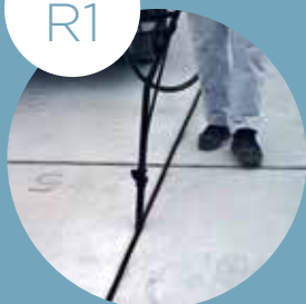
LA RÉFECTION D'UN JOINT
