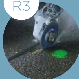
LE TRAITEMENT D'UN BÉTON DÉGRADÉ AVEC UN MORTIER
