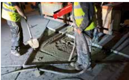
Coulage du béton
