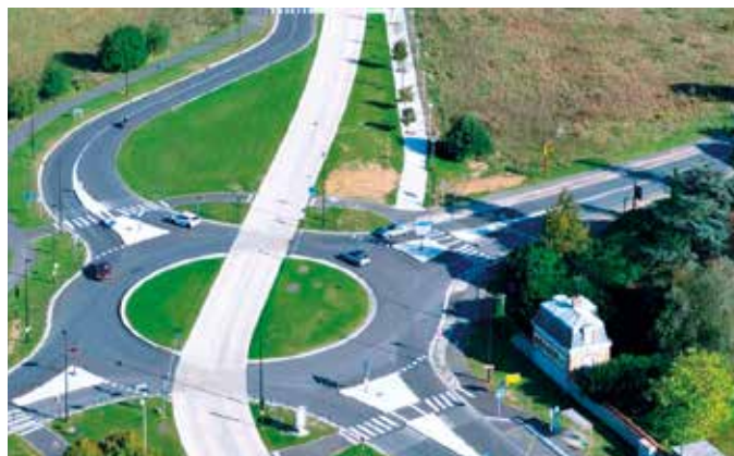
Surface de béton hydrorégénérée
