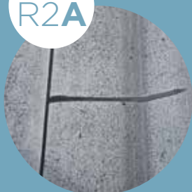
LE SCHELLEMENT DE FISSURE AVEC UN PRODUIT BITUMINEUX ÉLASTOMÈRE
