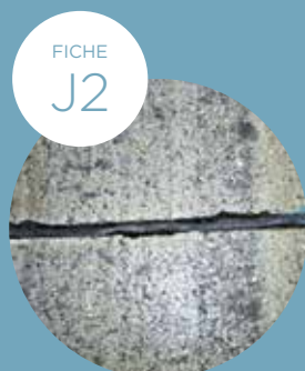
JOINT DE RETRAIT OU DE CONSTRUCTION (J2) OU DE DILATATION (J3) AVEC MASTIC ABIMÉ, DÉCOLLÉ, FISSURE OU MANQUANT
