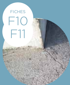
FISSURE À PARTIR D'UN COIN D'UNE SINGULARITÉ
