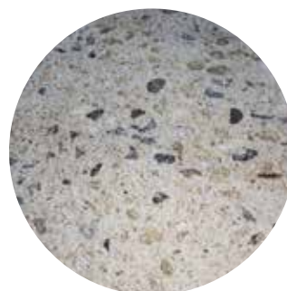
Surface de béton bouchardée
