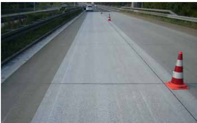
Surface de béton rabotée
