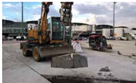
Enlèvement du bloc
