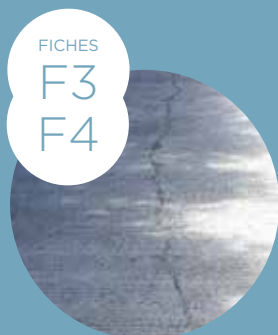
FISSURE LONGITUDINALE
