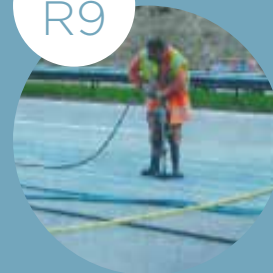
L'INJECTION SOUS DALLE
