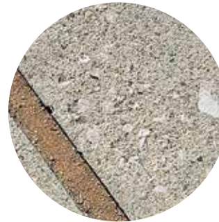
Surface de béton hydrosablée
