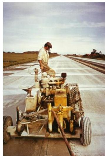
Figure 38- Machine spécifique pour scier le joint longitudinal
