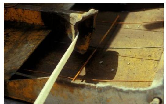
**Figure 37- Introduction d'une bande de mousse dans l'amorce de fissuration moulée du joint longitudinal**
