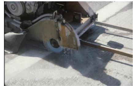
Figure 6- Sciage d'un joint transversal
