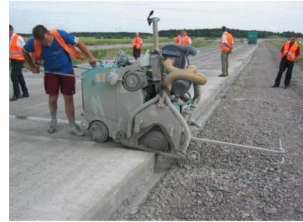
**Figure 15- Sciage de l'amorce de fissuration**
