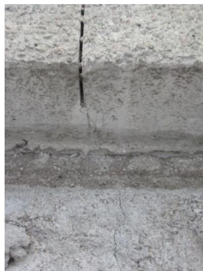
Figure 40- Sciage sur un tiers de l'épaisseur et fissure sous l'amorce
