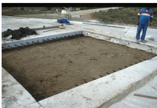
Figure 95- Dalle évacuée et préparation du coulage de la nouvelle dalle
