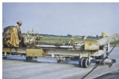
Figure 113- Machine spécifique à quatre lames pour scier le joint transversal
