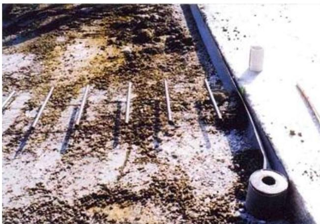
**Figure 55- Bande de mastic bitumineux préfabriquée, déroulée contre la paroi verticale constituée par un ancien béton qui sera maintenu, afin d'éviter des fissures de sympathie dans un élargissement ou une réparation**
