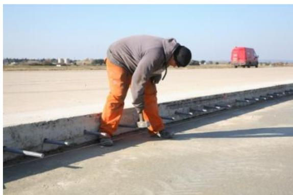
Figure 126- Joint longitudinal de construction - Mise en place des goujons avant coulage de la bande adjacente
