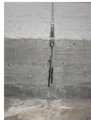
**Figure 17- Fissuration sous l'amorce moulée ou sciée**
