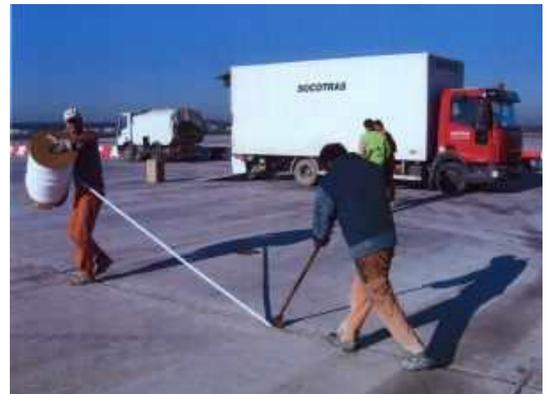
Figure 22- Pose du fond de joint
