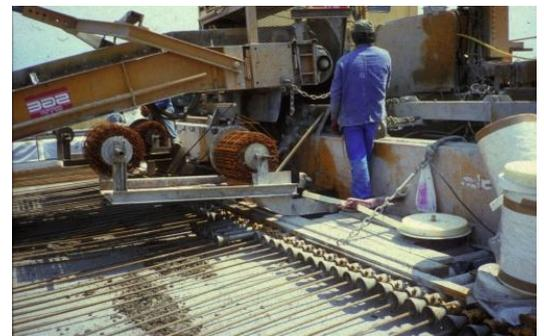
**Figure 36- Avant de la machine à coffrage glissant avec l'introduction d'un treillis faisant office de fer de liaison, et bande de mousse dans l'amorce de fissuration moulée du joint longitudinal**
