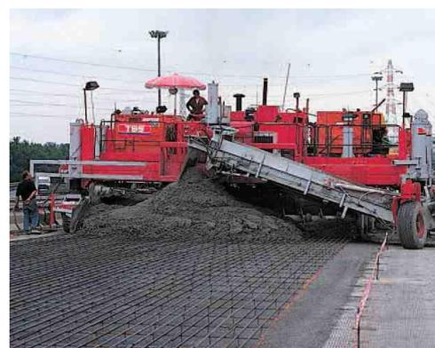
Figure 50- Mise en place du béton retardé
