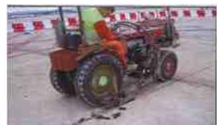
Figure 9- Tracteur avec soc pour dégarnissage de joints
