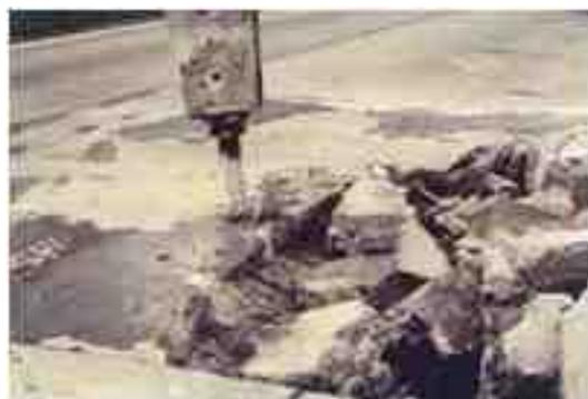
Figure 94- Démolition d'une dalle pour réparation
