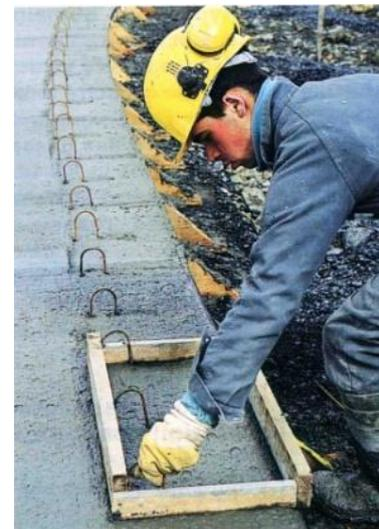
**Figure 81- Bordure partiellement intégrée au revêtement**
