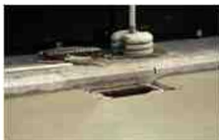
Figure 100- Remblayage de la tranchée avec des matériaux autocompactants et coulage du [béton de roulement](#)
