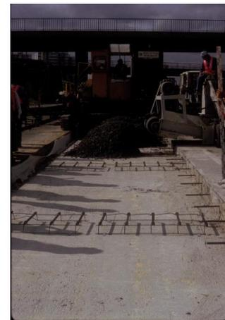
Figure 53- élargissement d'un revêtement ne comportant pas de clé: celle-ci a été remplacée par des goujons
