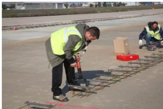
Figure 123- Joint longitudinal de retrait : mise en place des goujons sur panier avant coulage de la bande
