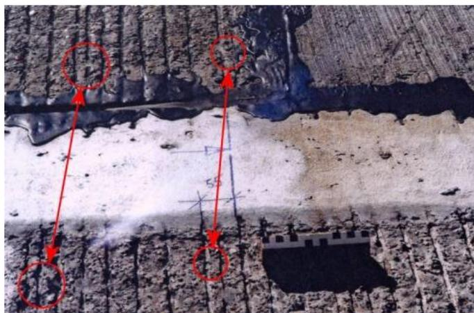
Figure 41- Glissement d'une extrémité libre de BAC mise en évidence par le striage transversal de surface : environ 5 cm
