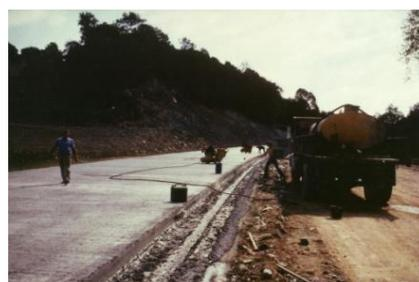
Figure 112- Atelier de sciage : scies monolames exécutant les joints transversaux et tonne à eau pour le refroidissement des disques
