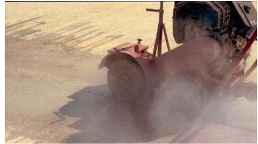
Figure 88- Réalisation simultanée de l'élargissement pour le produit d'étanchéité, et du chanfreinage
