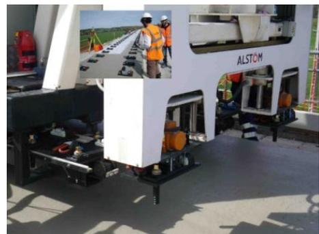
Figure 93- Fixation des rails sur « selles » introduites et réglées dans le béton frais. Procédé Appitrac-ALSTOM
