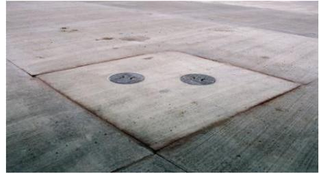
Figure 70- Vues d'une émergence en coin de dalle: bouches d'avitaillement d'aéronefs dans un revêtement de stationnement sur un aéroport
