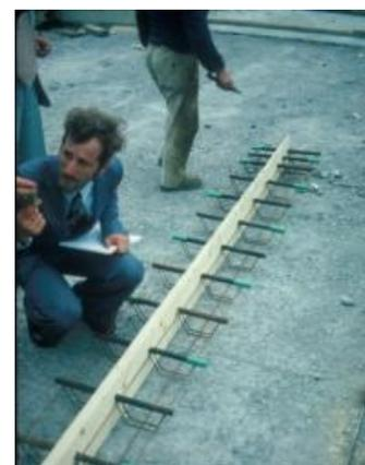
Figure 57- Planche compressible et goujons pour coffrage d'un joint de dilatation<sup>1</sup>
