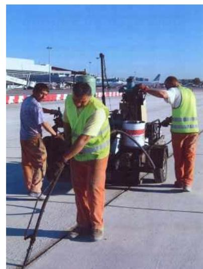
Figure 23-Garnissage d'un joint
