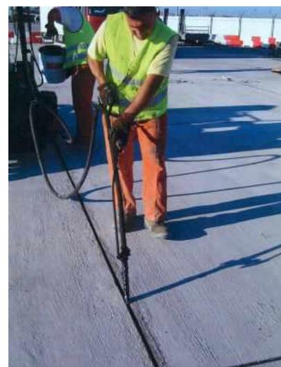
Figure 24- Garnissage d'un joint (détail)
