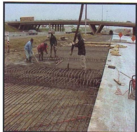
**Figure 60- Réalisation d'une culée d'ancrage**
