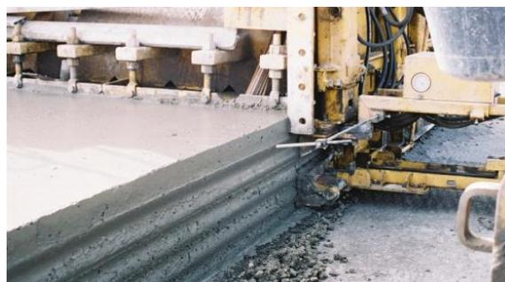
Figure 128- Moulage d'une clé sinusoidale- Les barres d'ancrages seront mise en place par forage et scellement
