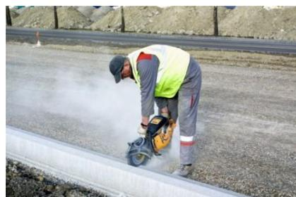
Figure 111- Sciage de joint sur bordure de trottoir
