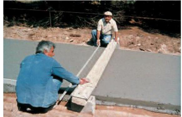
Figure 13- Réalisation d'un joint moulé dans le béton frais
