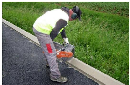
Figure 33-Sciage d'un joint de retrait/flexion dans une bordure de trottoir avec une scie manuelle
