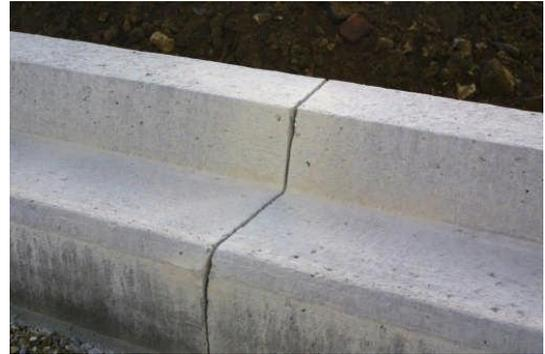
Figure 31- Joint de retrait/flexion dans une bordure de trottoir
