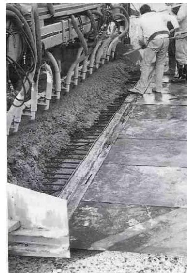
**Figure 46- Mise en place manuelle du béton; les ouvriers circulent sur les armatures protégées par des panneaux**
