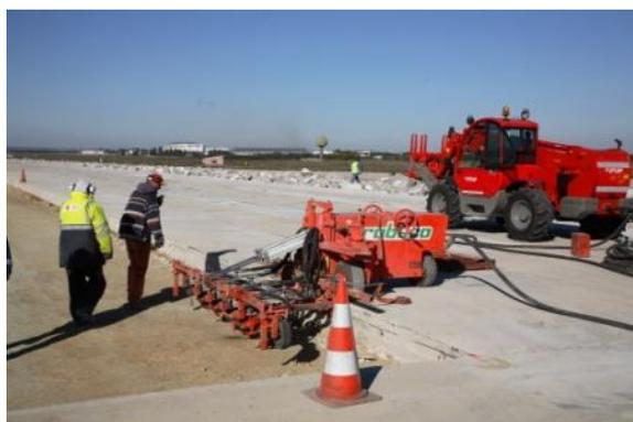
Figure 125- Joint longitudinal de construction - Forage du béton durci jeune
