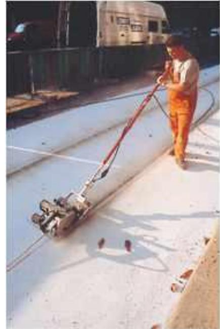
Figure 80- Matériel de sciage spécifique au BCMC
