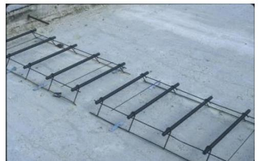
Figure 11- Second exemple de panier à goujons, qui est fixé sur la fondation
