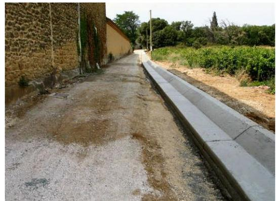
Figure 32- Joints à intervalles réguliers dans un fil d'eau
