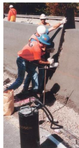
Figure 28- Sciage manuel du béton frais pour la réalisation d'un joint dans une barrière de sécurité
