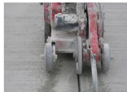
**Figure 18- Chanfreinage du logement du produit d'étanchéité**
