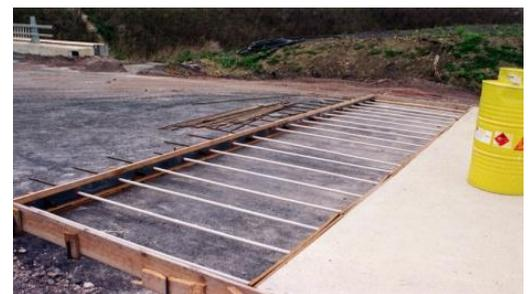
Figure 64- Dalle coffrée prête à être coulée
