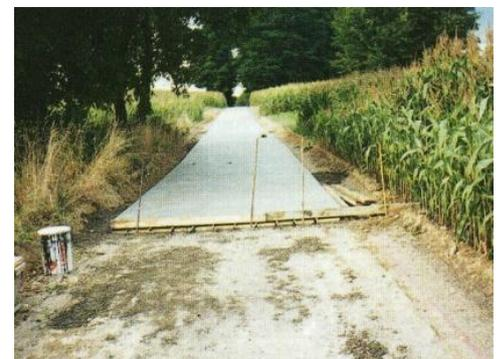
Figure 43- Réalisation d'un joint transversal de construction
