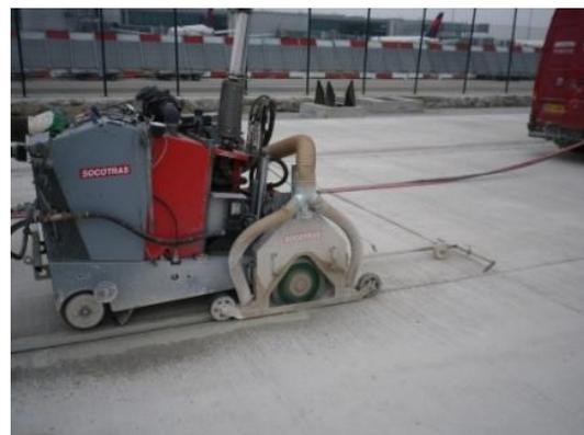
Figure 39- Scie avec aspirateur à laitance de sciage intégré
