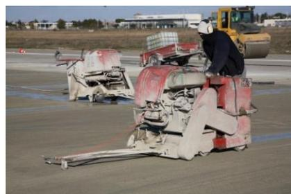
Figure 114- Atelier de sciage : scies monolames exécutant les joints transversaux et longitudinaux, en arrière-plan la réserve d'eau pour le refroidissement des disques
