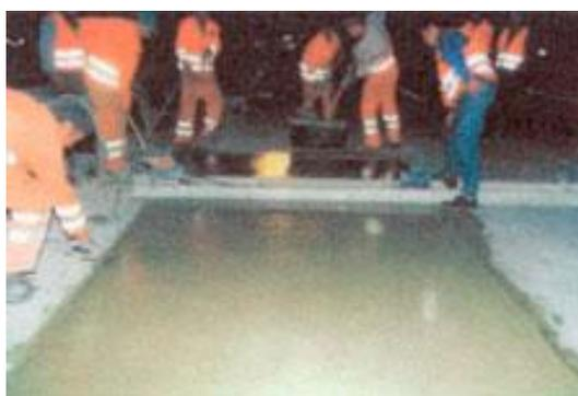
Figure 96- Reconstitution de la dalle démolie en béton généralement formulé notamment avec accélérateur de prise, pour permettre une remise en service après quelques heures de durcissement, exceptionnellement quelques jours
