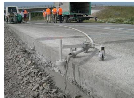
**Figure 16- Scie équipée d'un aspirateur à laitance de sciage**
