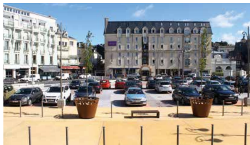
Parking en béton coloré, Casino de Trouville-sur-mer ©Mineral Service
