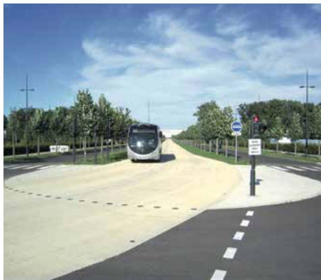
Plate-forme de Bus à Haut Niveau de Service (BHNS) en BAC sur béton maigre avec traitement de surface par hydrogommage, TZen Melun Sénart ©Eurovia
