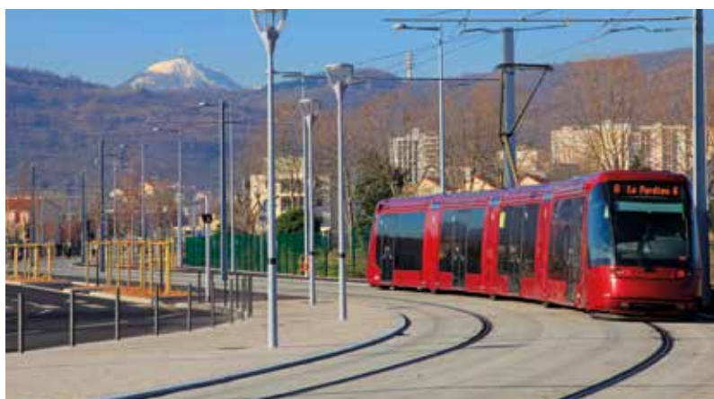
Plate-forme en béton pour le tramway sur pneus de Clermont-Ferrand ©Eiffage Infrastructures
