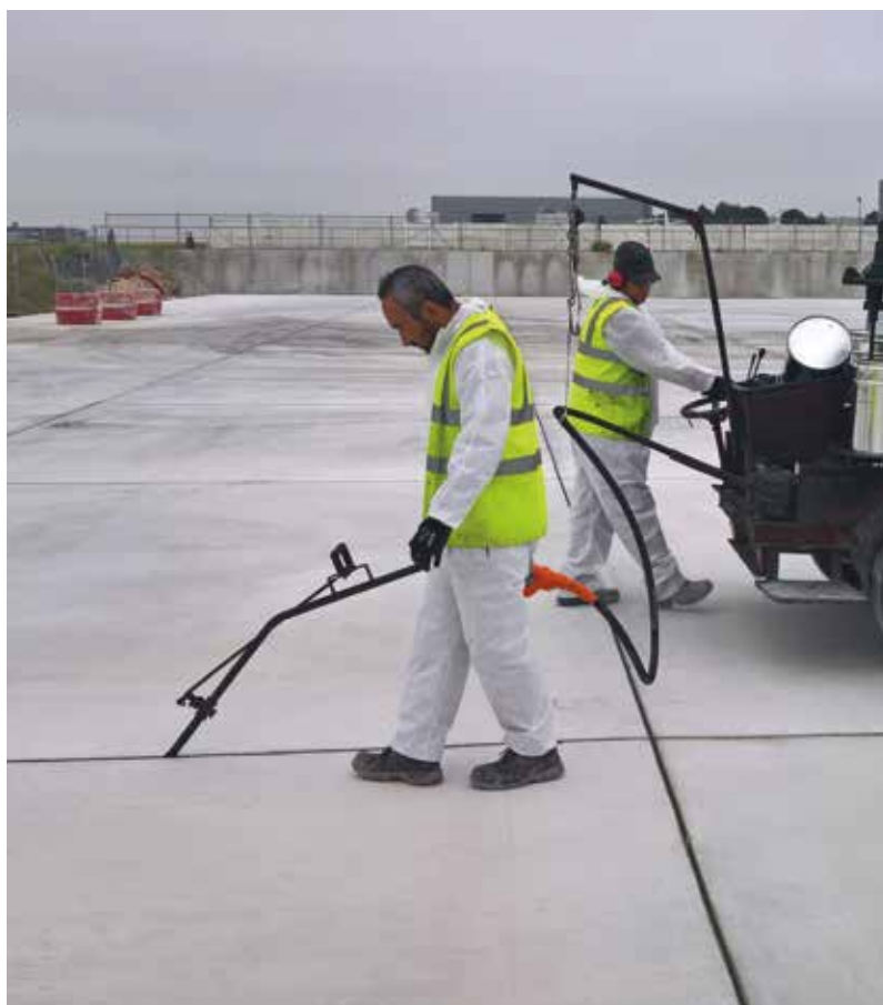
Garnissage d'un joint de retrait, Vire ©Socotras
