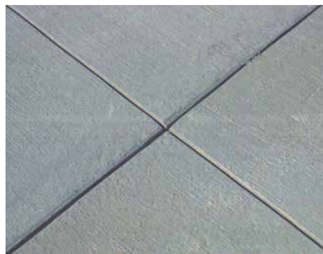
JOINTS DE RETRAIT SCIÉS ET CHANFREINÉS ©AER
