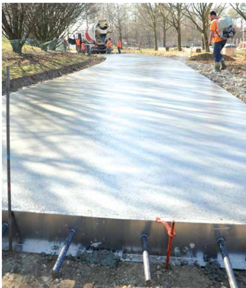
Joint de dilatation goujonné ©CIMbéton
