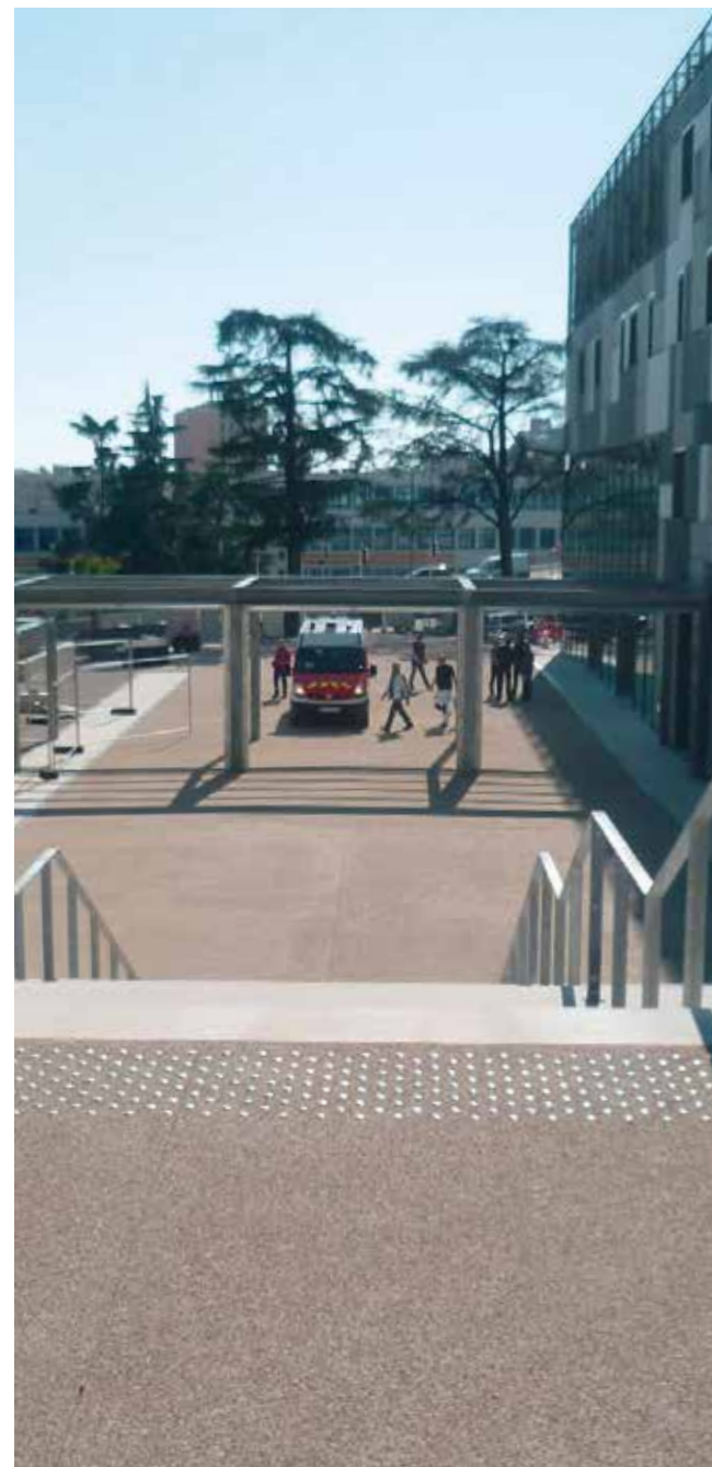
Parvis en béton désactivé de l'Hôpital Nice Pasteur 2, avec accès pompier ©MB Constructions
