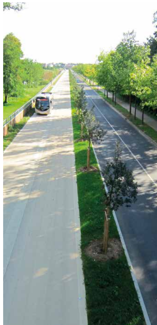
Plate-forme en béton armé continu pour le T zen, Melun-Sénart ©CIMbéton
