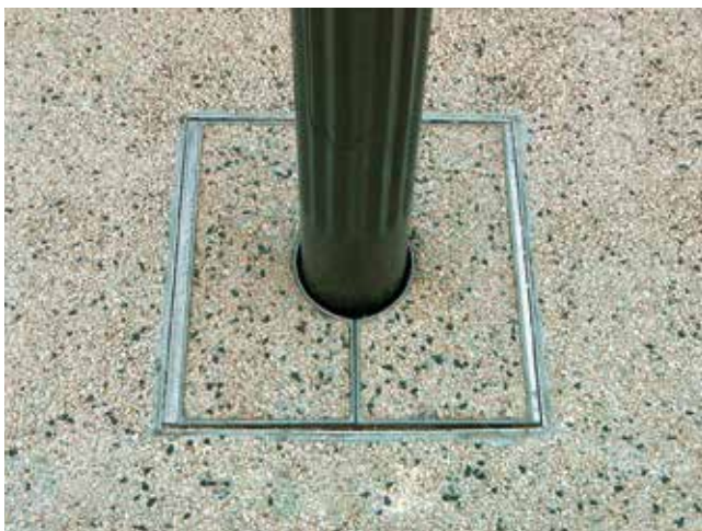
Isolation d'un pied de candélabre ©SOLS
