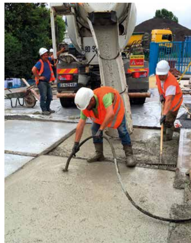
Vibration par aiguille vibrante ©Mineral Service
