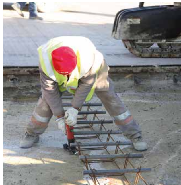
Positionnement des goujons pour le joint transversal goujonné ©AER
