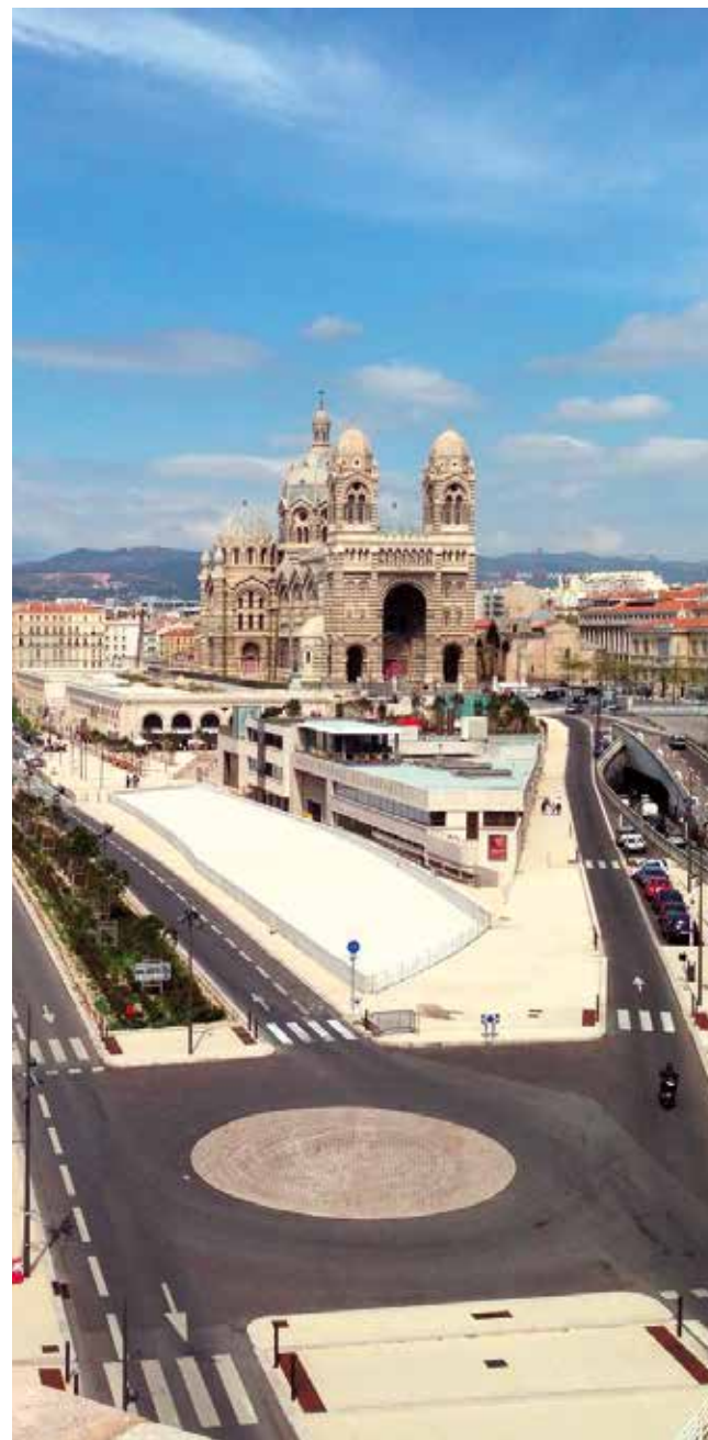
Vue générale des aménagements en béton désactivé et bouchardé autour de la cathédrale de la Major (cathédrale Sainte-Marie-Majeure), Marseille ©CIMbéton
