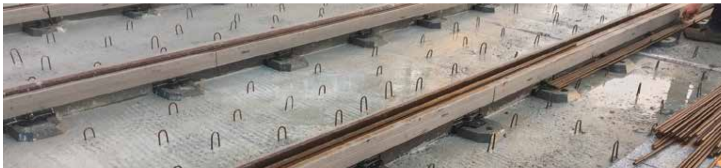
Connecteurs pour liaison béton de revêtement sur béton d'assise sur chantier de tramway ©Mineral Service
