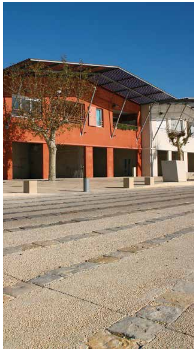
Aménagement en béton désactivé avec des bandes structurantes en pierres naturelles, Port-Saint-Louis ©RCR Déco France
