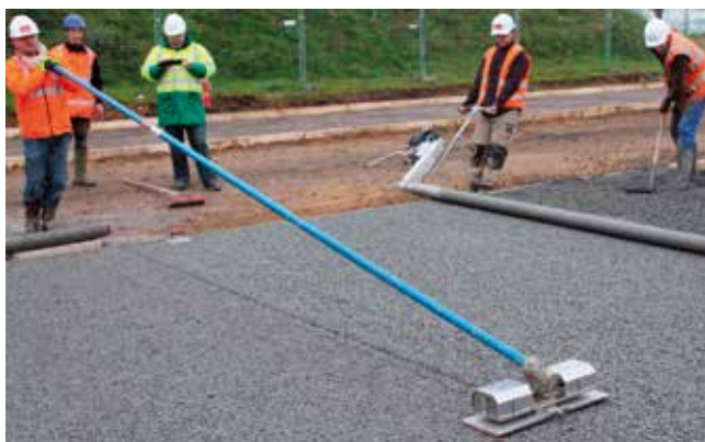
Joint moulé dans un béton drainant ©Mineral Service
