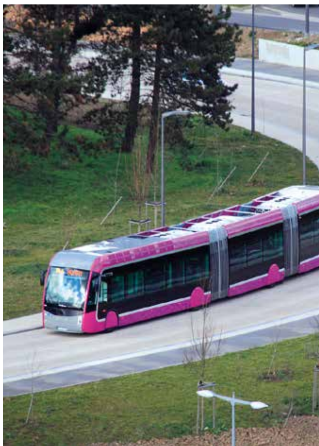
Plate-forme en béton à joints goujonnés pour le bus en site propre (BHNS) de Metz ©Eiffage Infrastructures
