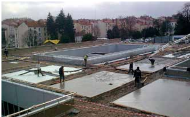
Exemple d'un chantier où le phasage et le parti d'aménagement imposent une multitude de joints de construction. ©MCA
