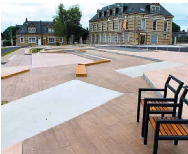
Aménagement en béton imprimé façon bois, La-Mailleraye-sur-Seine ©Mineral Service
