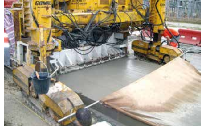
En sortie de machine à coffrage glissant, le béton est lisse et fermé. Le passage d'une toile de jute permet, en retirant la laitance, de donner une micro-rugosité à la surface du béton. ©CIMbéton
