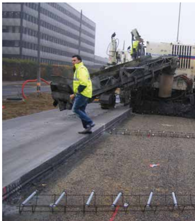
Positionnement des goujons sur leur support au droit des futurs joints sciés avant bétonnage à la machine à coffrage glissant (à signaler les marques sur le bord du béton signalant l'endroit exacte du sciage à venir) ©Signature
