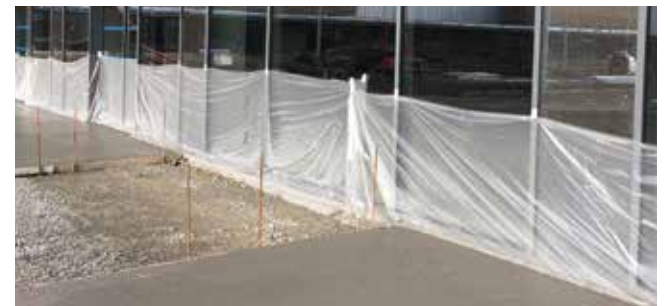
Protection des abords de chantier ©RCR déco Bretagne
