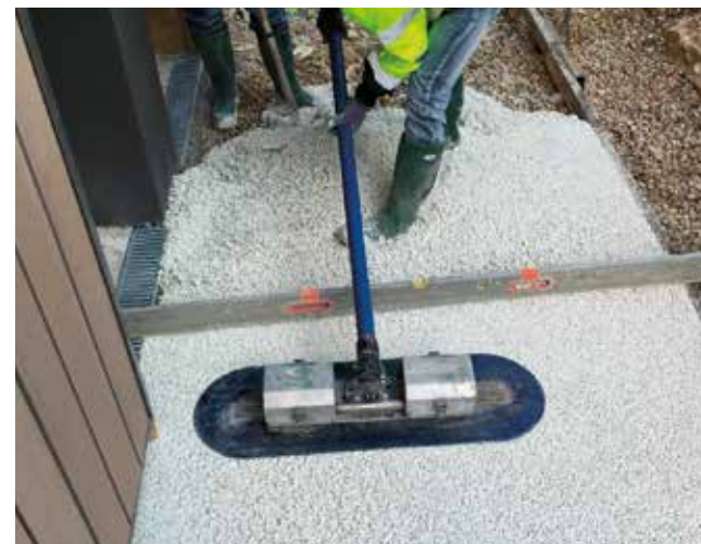
Finition du béton par lisseuse vibrante pour béton drainant ©MIGMA
