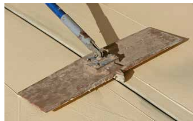
Joint moulé dans un béton dense ©Moderne Méthode
