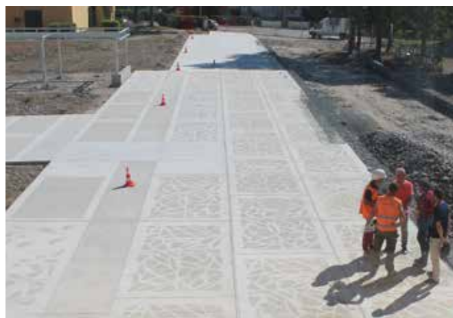
Visite de chantier au collège Jules Verne à Rivery @Mineral Service
