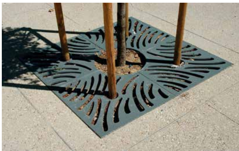
Joint d'isolement autour d'un pied d'arbre ©SOLS
