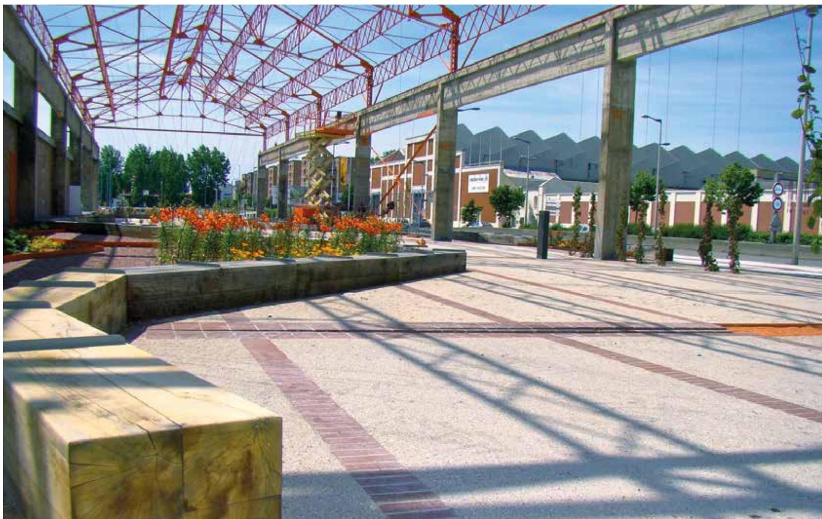
Aménagement en béton désactivé avec des bandes structurantes en éléments modulaires, Halle Dreser, Le Havre ©Mineral Service
