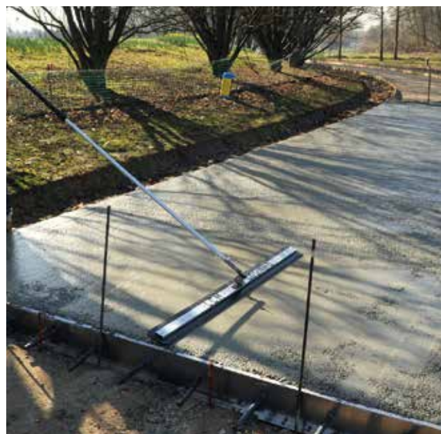
Joint de dilatation - Parc des Chanteraines ©CIMbéton
