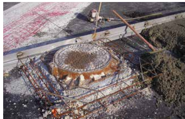
Renforcement par une cage d'armature autour d'un tampon ©SOLS
