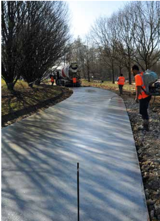
Pulvérisation du produit désactivant, faisant office de cure, après l'opération de lissage du béton. Parc des Chanteraines ©CIMbéton
