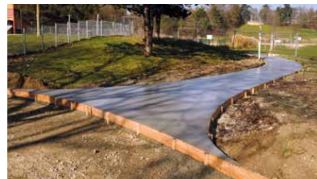
Coffrage avant bétonnage, Parc des Chanteraines, Hauts-de-Seine ©CIMbéton
