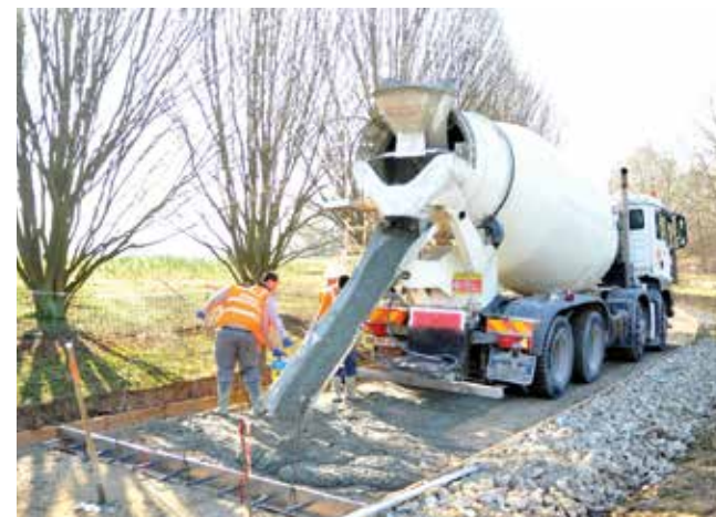
Approvisionnement du béton ©CIMbéton
