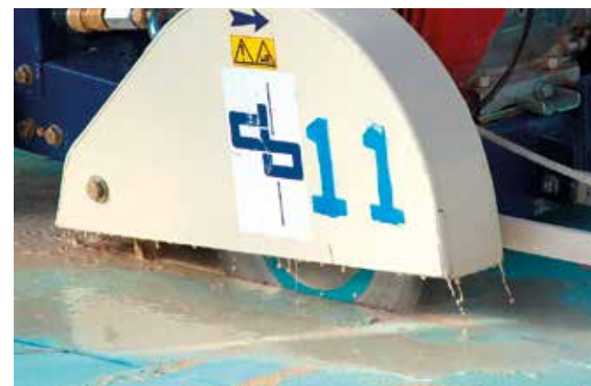
Détail sciage dans le béton ©SOLS
