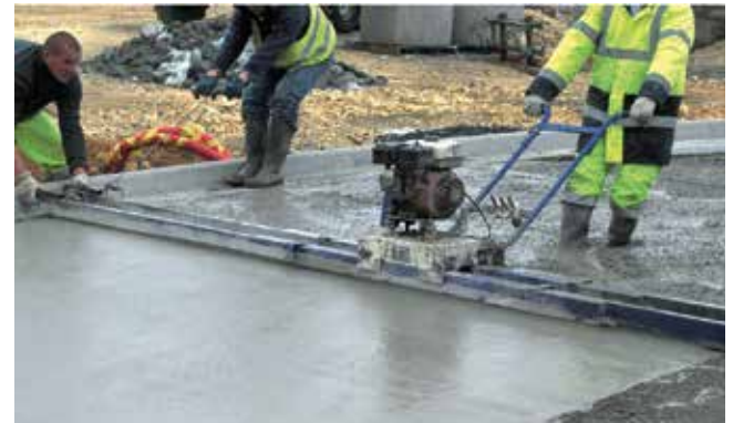
Mise en œuvre du béton à la règle vibrante ©CIMbéton
