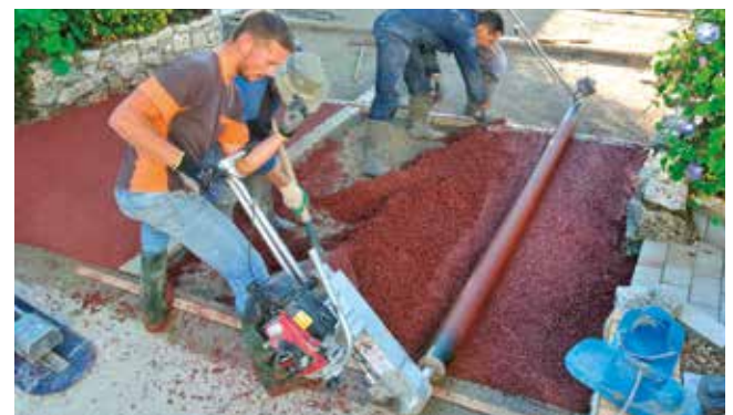
Mise en œuvre du béton au striker ©GCP
