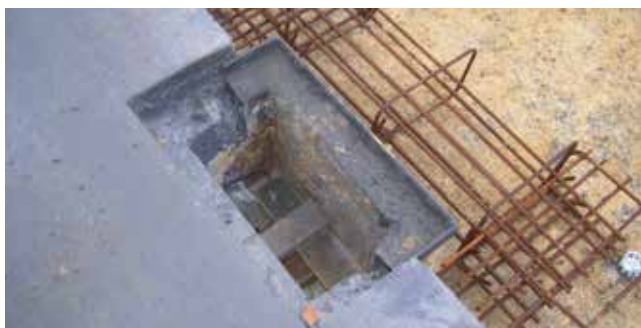
Chaînage bordant un avaloir ©CIMbéton
