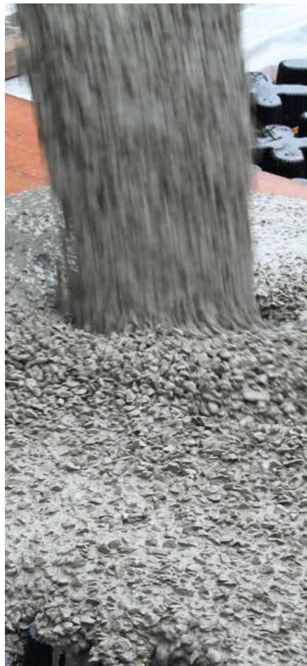
Coulage de béton frais ©Moderne Méthode
