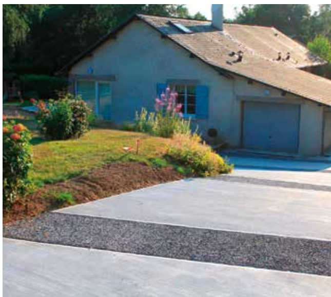
Descente d'habitation en alternance de béton drainant et balayé ©EFCAT
