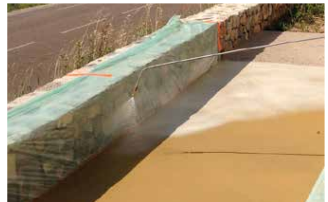
Protection des abords de chantier ©MIGMA
