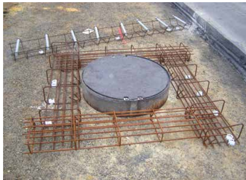
Chaînage autour d'un regard ©CIMbéton
