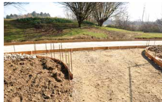
Coffrage avant bétonnage, Parc des Chanteraines, Hauts-de-Seine ©CIMbéton
