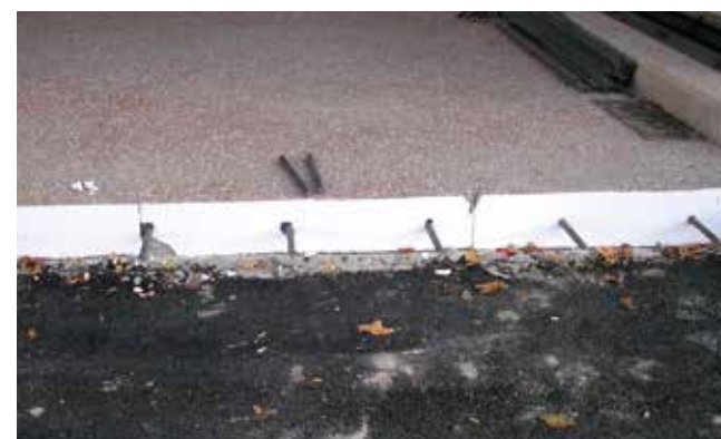
Joint de construction transversal goujonné ©SOLS
