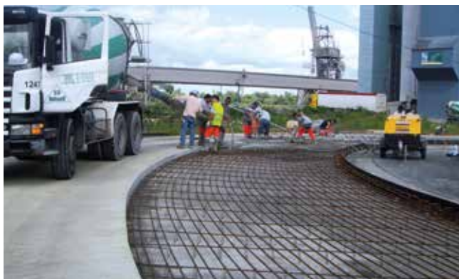
Mise en œuvre d'un giratoire en béton armé continu ©CMR Exedra
