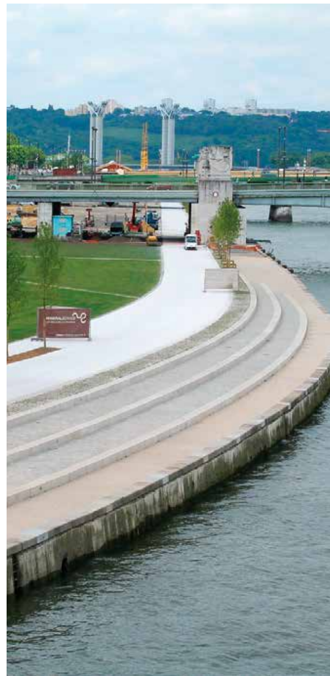
Aménagement des quais en béton, Rouen rive gauche ©Mineral Service
