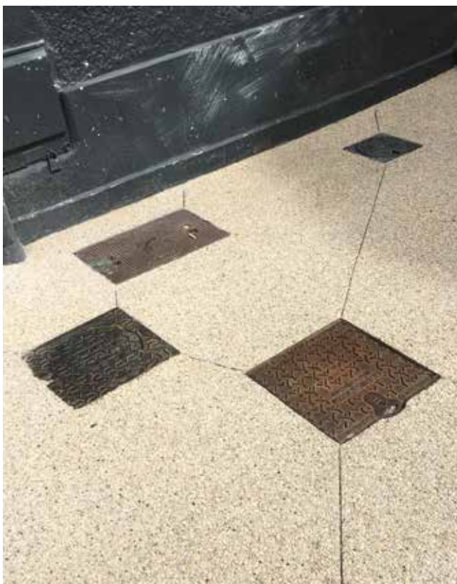
Dispositions constructives autour d'émergences ©J. Abdo
